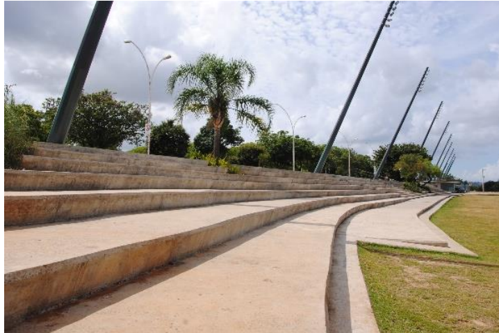
Figura 4. 18.: Arquibancadas Fonte: a autora (2019)
