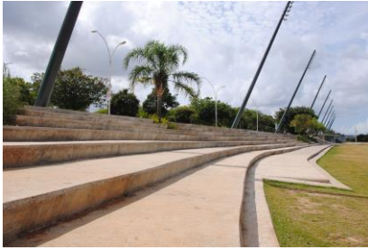
Figura 3. 48.: Arquibancadas Fonte: a autora (2019)
