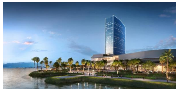
Figura 3. 63.: Edifício comercial Fonte: Melnick Even (2019)
