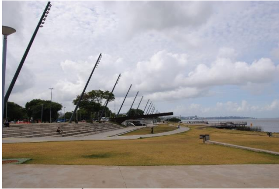
Figura 3. 24.: Área do Trecho 1 da Orla do Guaíba após a reforma Fonte: a autora (2019).
