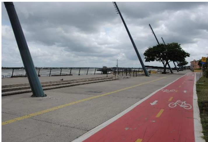
Figura 4. 59.: Ciclovia Fonte: a autora (2019)
