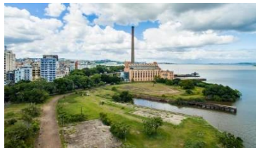
Figura 3. 65.: Cais Mauá – setor Gasômetro
