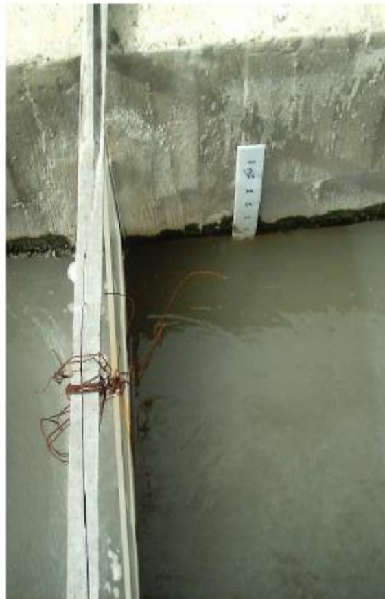
Estructura de aforo y repartición de caudales a las lagunas facultativas
