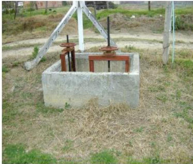
Estructura de entrada
