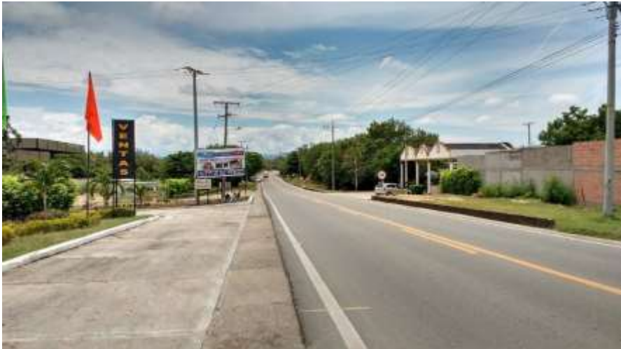
Foto propia: Vía Nariño – Guataque – Corredor vial
