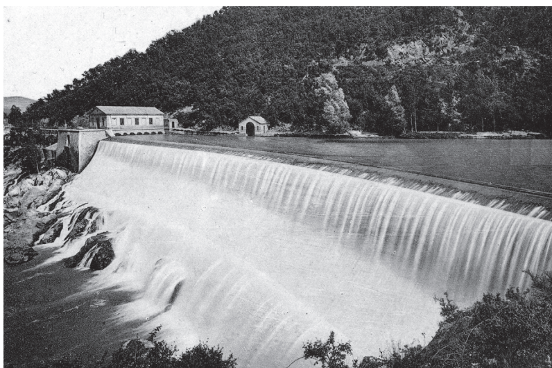
Figura 3: La presa de El Pasteral i la cambra d'aigua. Font: autor.
