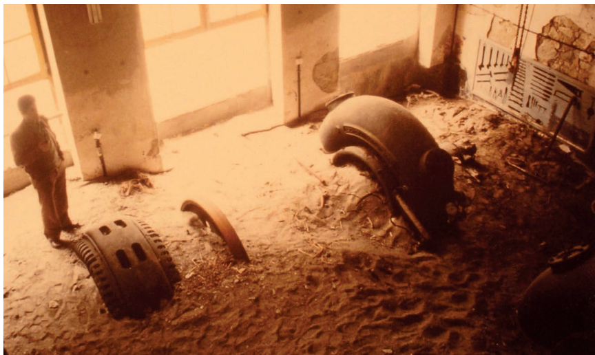
Figura 11: La central de Pont de Bar després de la riuada, l'any 1983. Font: PEUSA.
