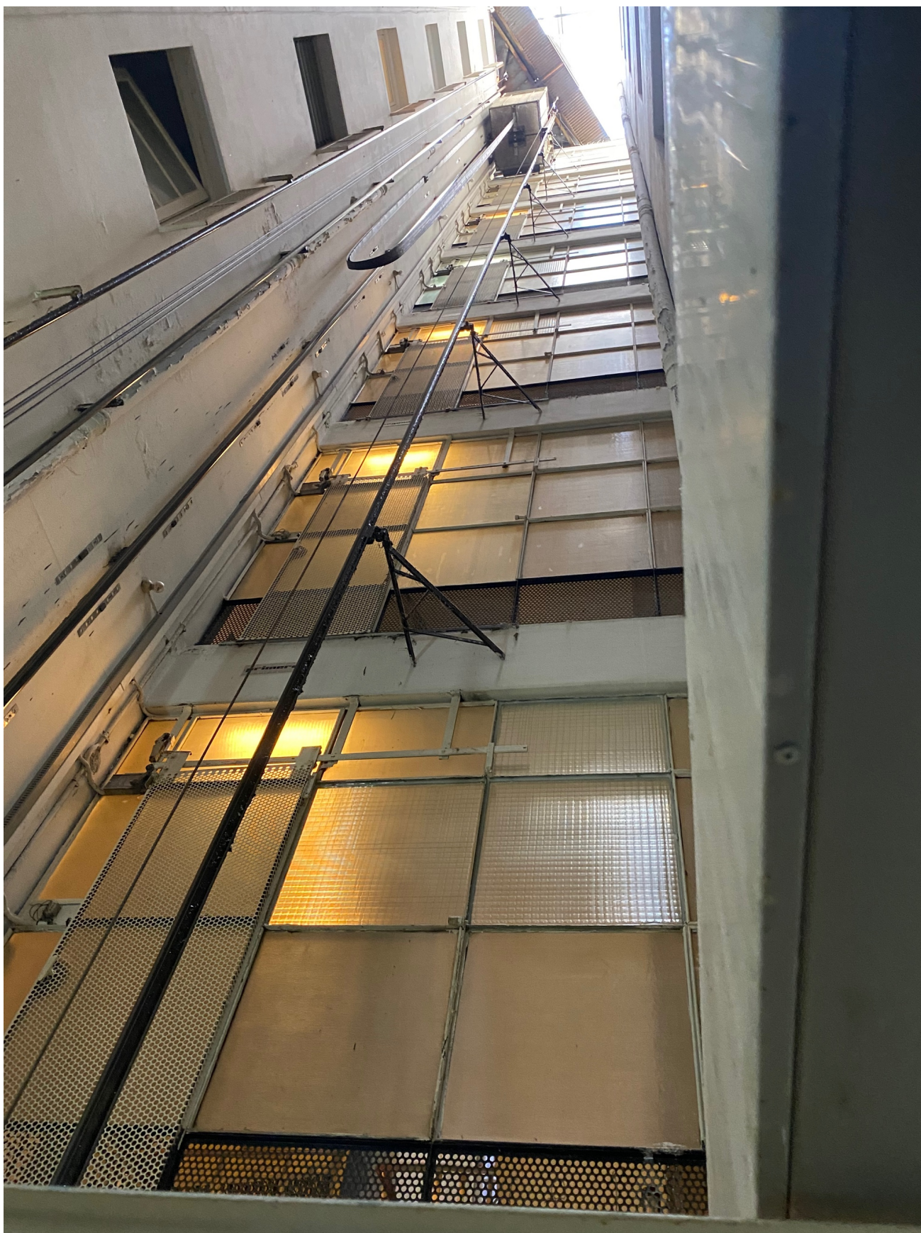
Vista del parament dels replans d'escala des de l'interior de la caixa de l'ascensor
