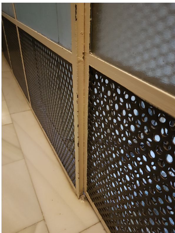
Detall de la planxa perforada que configura la zona inferior del parament
