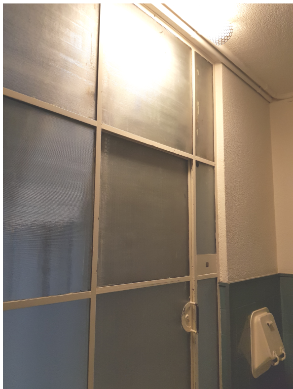
Vistes de la part superior i part inferior de l'entrega de la porta de l'ascensor al parament
