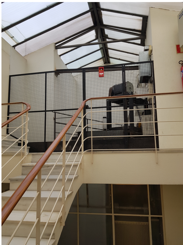
Vista del badalot d'escala, la maquinària de l'ascensor i l'estructura superior de suport dels treballs verticals
