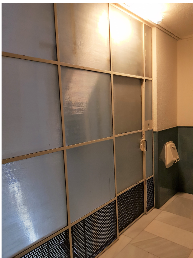
Vista en general de la porta de l'ascensor integrada al parament
