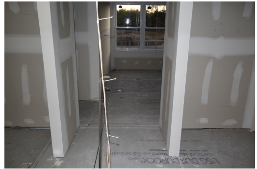
(d) Kitchen Gas and Thermocouple Tree
