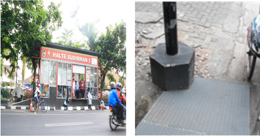
Gambar 2. rampa halte Trans Jogja berhadapan langsung dengan pot eksisting serta terganggu oleh keberadaan tiang lampu jalan (Sumber: Laporan Life Design Project, 2009)
