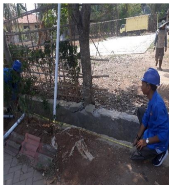
Gambar 13 Pemasangan Tiang Lampu Penerangan.
