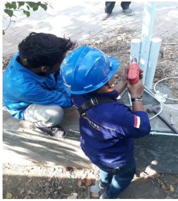
Gambar 14 Pemasangan Tiang Lampu Penerangan.
