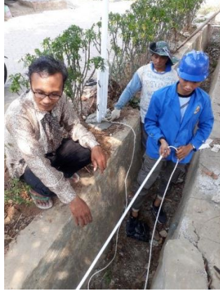
Gambar 11 Proses Pemasangan Pipa Konduit Pada Kabel.
