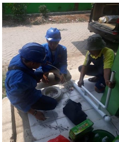
Gambar 5 Proses Pemasangan Kabel Tiang Lampu Penerangan.
