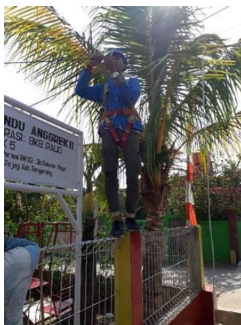
Gambar 10 Proses instalasi kabel antar tiang.
