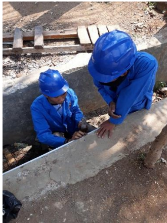
Gambar 12 Proses Pemasangan Pipa Konduit Pada Kabel.
