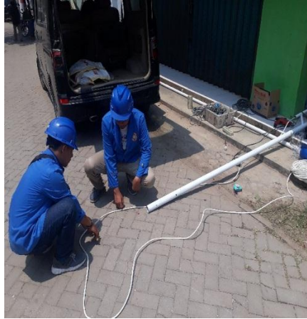
Gambar 6 Proses Pemasangan Kabel Tiang Lampu Penerangan.
