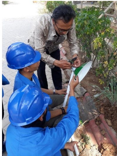
Gambar 7 Proses Pemasangan Lampu dan Kap Lampu Penerangan.
