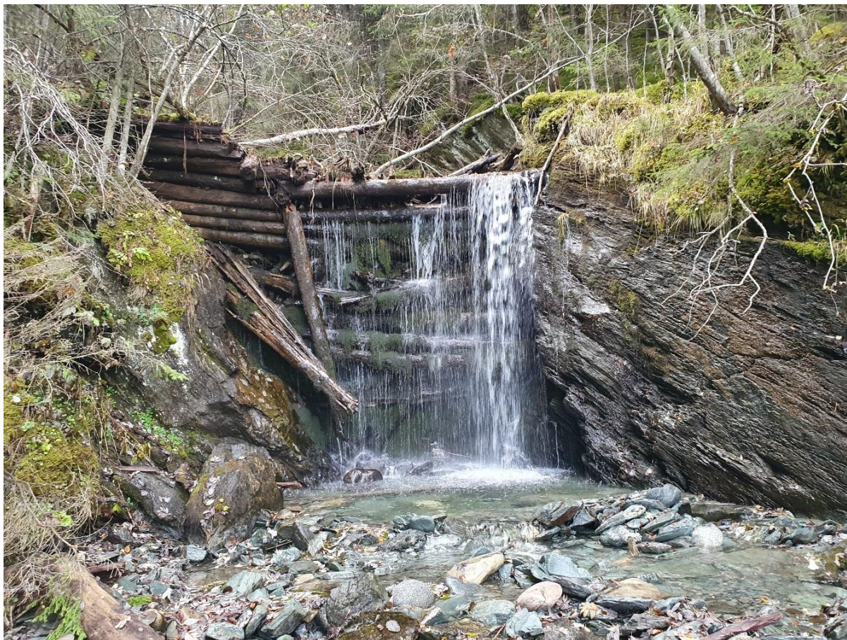
Bilde 140. Gammel dam er lokalisert der den tidligere naturlige vandringsbarrieren for anadrom laksefisk i Uva også inntraff. Foto: Øyvind Solem, NINA.
