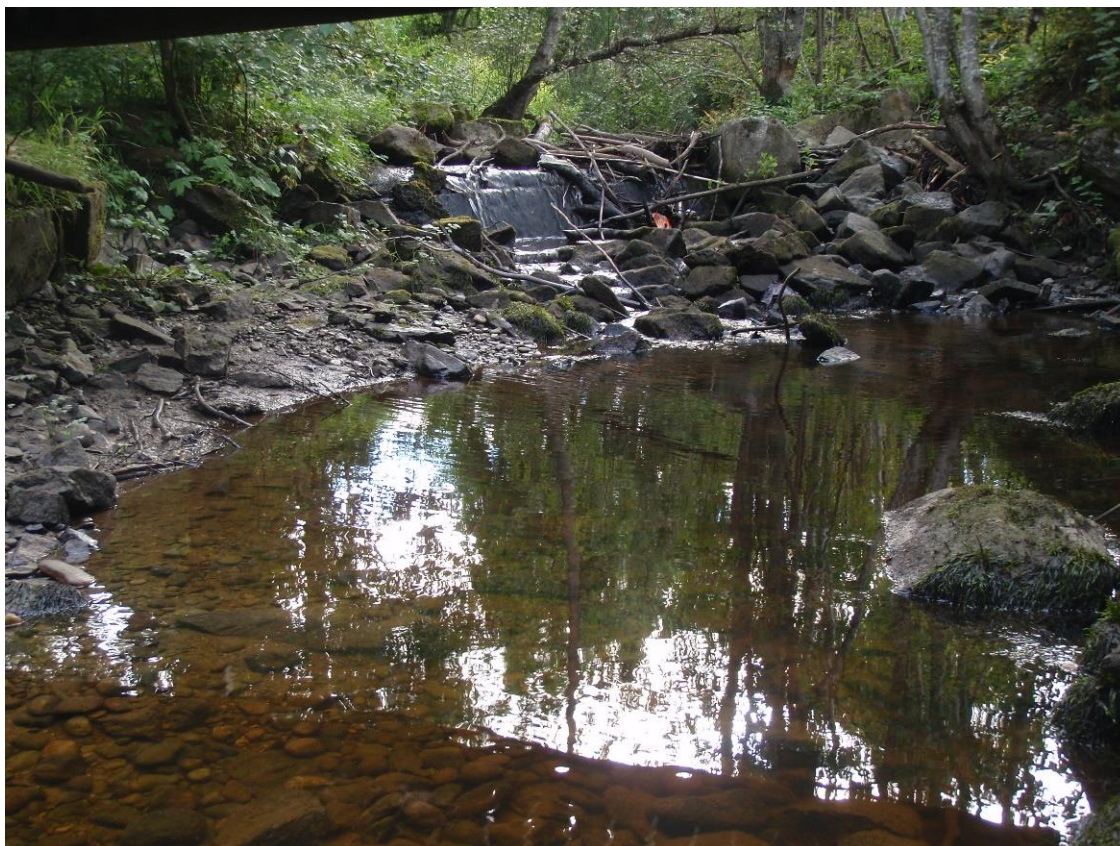
Bilde 3. Terskel i nedre del av Evjensbekken i september 2010. Bildet er tatt ved lav vannføring i både Evjensbekken og Orkla samt fjære sjø. Foto: Morten Andre Bergan, NINA.
