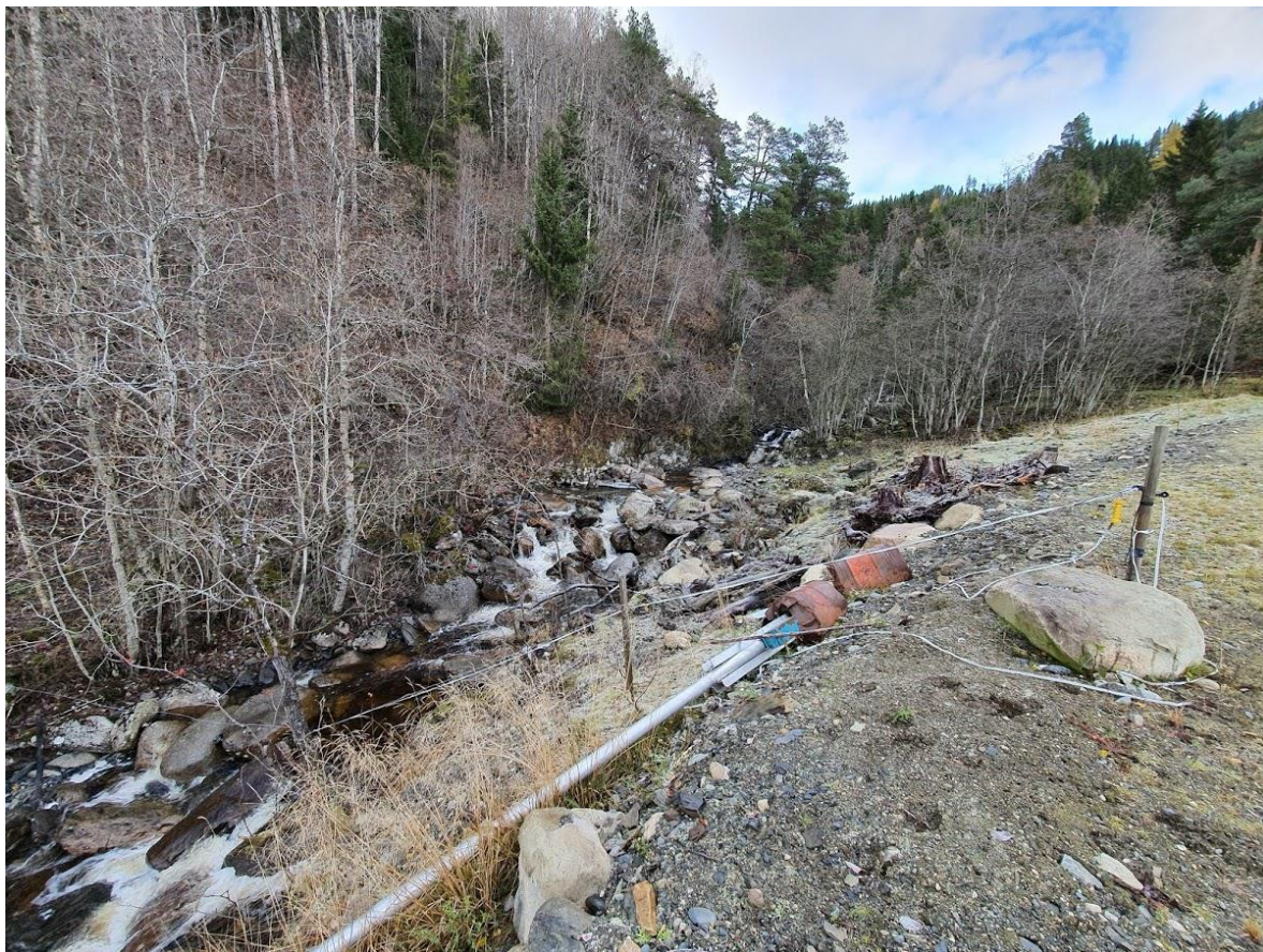
Bilde 97. Området der traktorveien er flytte nærmere og delvis ut i vassdraget. Større steiner danner i dag små fosser, som kan utgjøre vandringshinder for anadrom laksefisk. Foto: Øyvind Solem, NINA.
