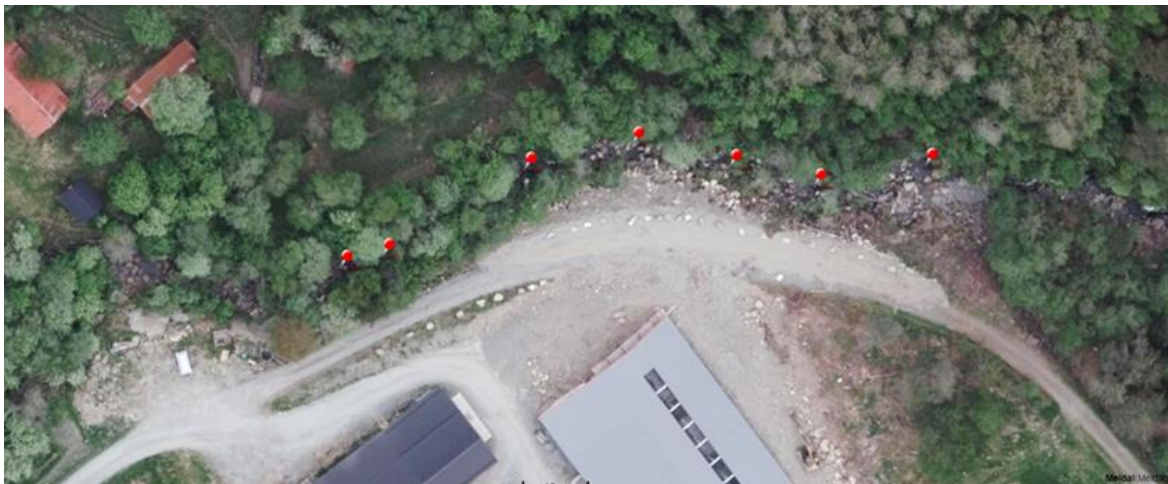
Bilde 95. Område oppstrøms Ressveien, der en grusvei/traktorvei er flyttet ut mot, og delvis i, det opprinnelige bekkeløpet. Avsmalning av bekkeløp og utrast storstein i fra veianleggingen i bekkeløpet har skapt vanskeligere oppvandringsforhold for anadrom laksefisk. Røde markeringer viser bekkeløp. Ungfisktelling høsten 2019 ble gjennomført fra nest øverste røde markeringspunktet og oppover. Foto: www.finn.no
