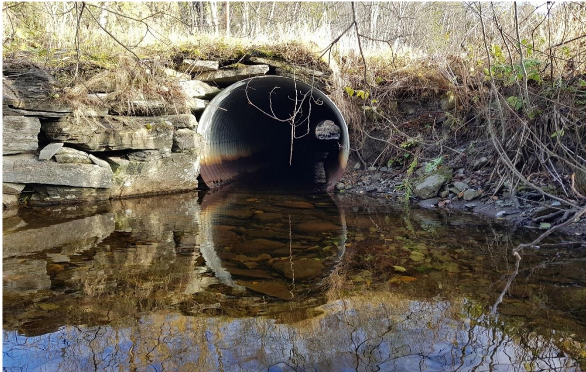
Bilde 171. Kulverten under Fv. 700 munner ut i en litt større kulp i nedre deler av Brea. Foto: Øyvind Solem, NINA.
