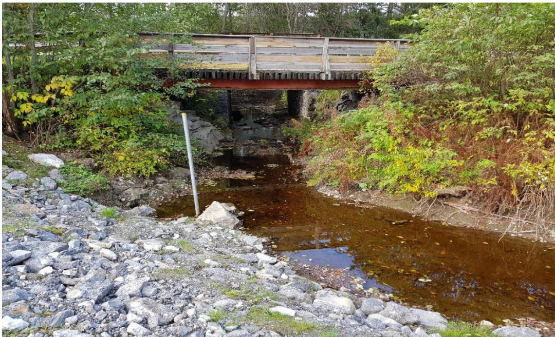
Bilde 2. Kulvert der Evjensbekken krysser Orkdalsveien. Foto: Øyvind Solem, NINA.
