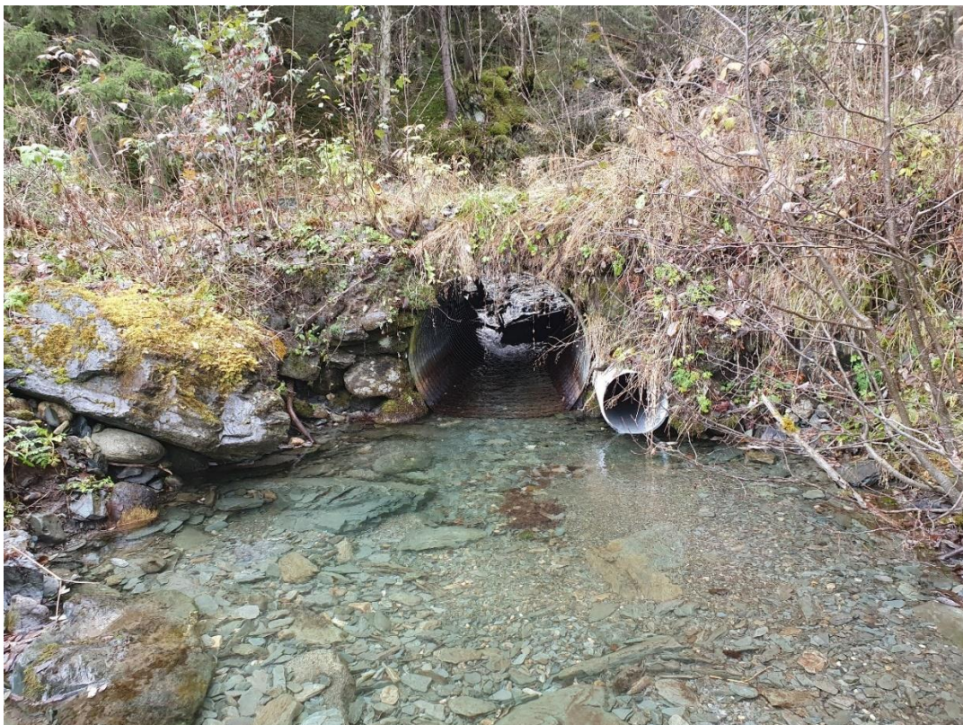
Bilde 141. Kulvert under traktorvei oppe ved vandringsbarriere kan være vandringshindrende på visse vannføringer som følge av store steiner på oversiden (skimtes gjennom røret). Foto: Øyvind Solem, NINA.
