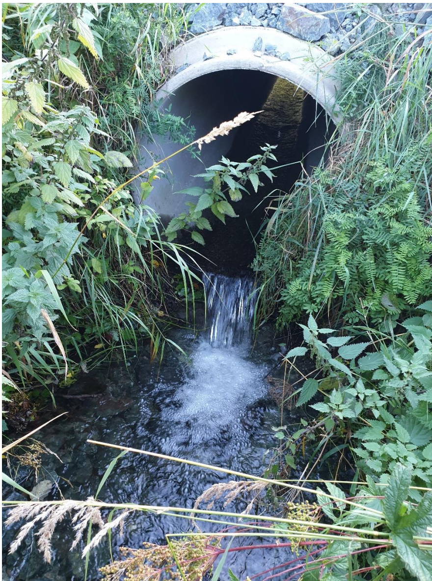
Bilde 167. Skørva er lagt i rør under avlingsvei om lag 150 meter nedstrøms Fv. Dette røret er sannsynligvis et hinder for fisk på de fleste vannføringer. Foto: Espen Holthe, NINA.
