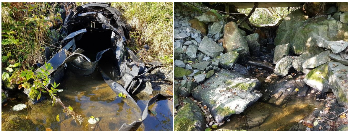
Bilde 30. Til venstre rør under Fv. 462. Til høyre foss under skogsbilvei på oversiden av Fv. Foto: Øyvind Solem.
