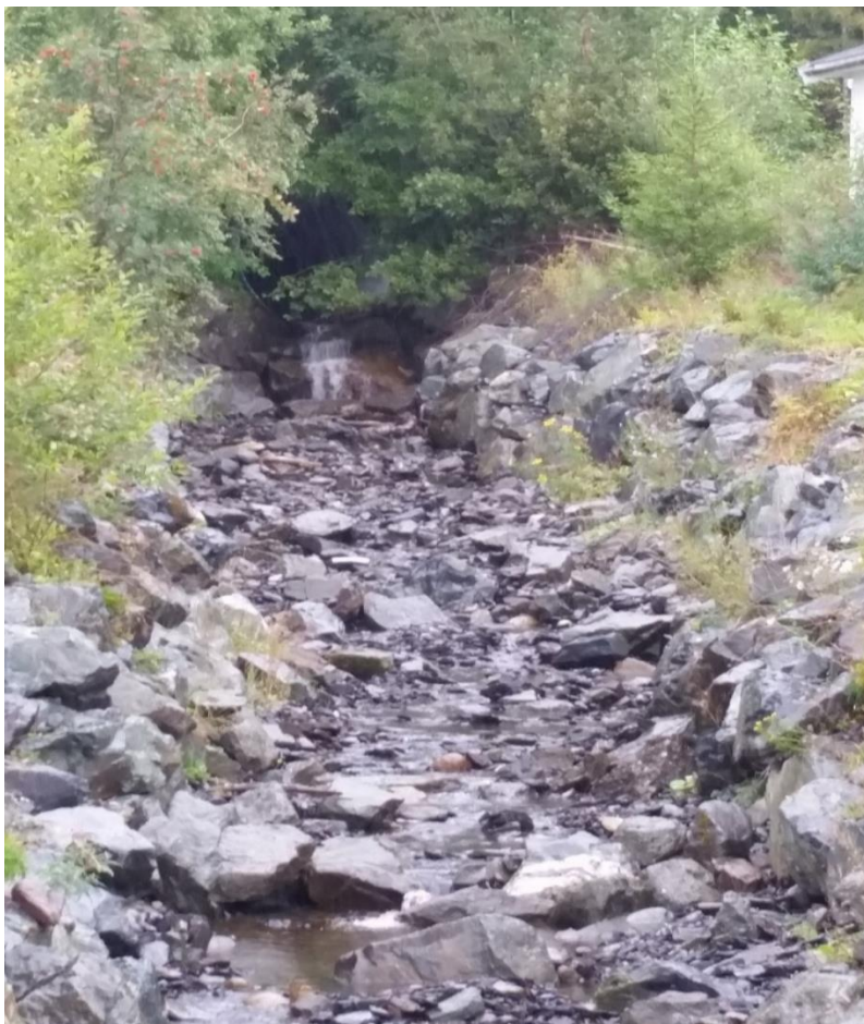
Bilde 100. Kanalisert bekk før lengre kulvert ved boligfelt og kryssing av Ressveien. Foto: Jan Gunnar Jensås.
