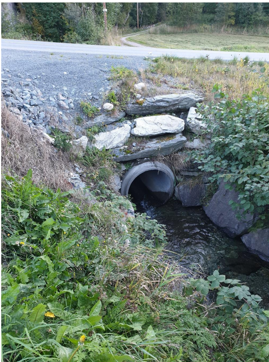
Bilde 166. Skørva er lagt i rør under Fv. Dette røret er sannsynligvis hinder for fisk på de fleste vannføringer. Foto: Espen Holthe, NINA.
