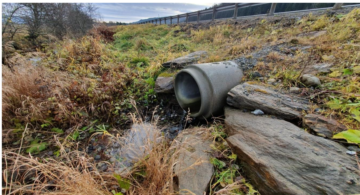
Bilde 43. Kulvert under Fv. 65 for mindre bekk fra vest. Vannføring høsten 2019 var vedlig lav selv om det i dagen før hadde regnet noe. Foto: Øyvind Solem, NINA.
