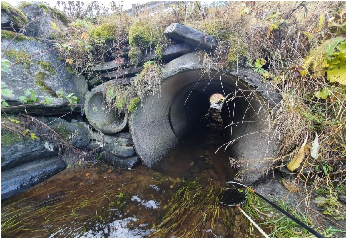
Bilde 42. Kulvert under Fv. 65 i Kjelbekken representere ingen vandringshinder for anadrom laksefisk. Foto: Øyvind Solem, NINA
