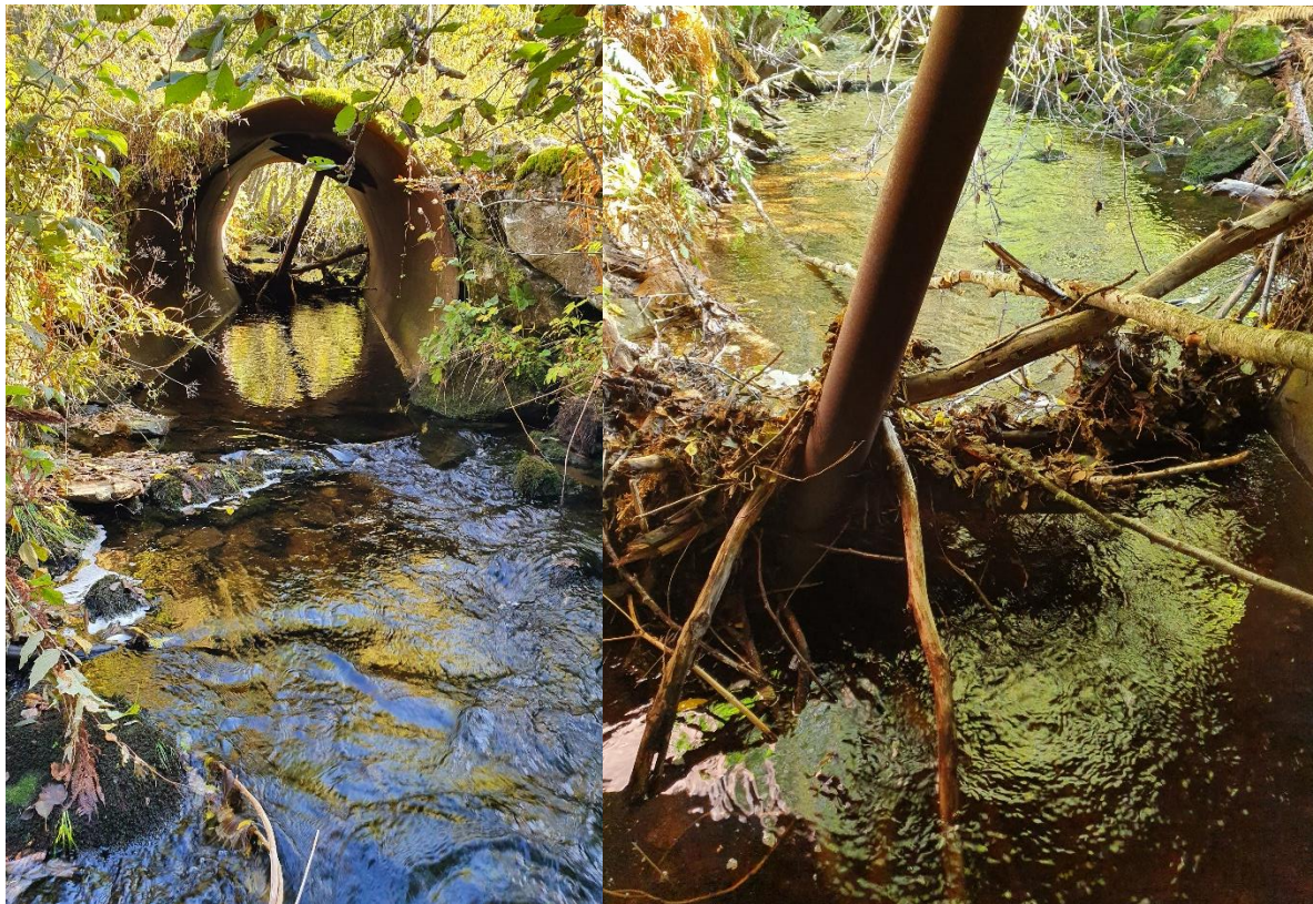
Bilde 188. Delvis nedsenket kulvert ved utløpet av bekken til Grøa. Kvist og kvast kan bygge seg opp og hindre oppgang på enkelte vannføringer. Foto: Torgeir B. Havn, NINA.
