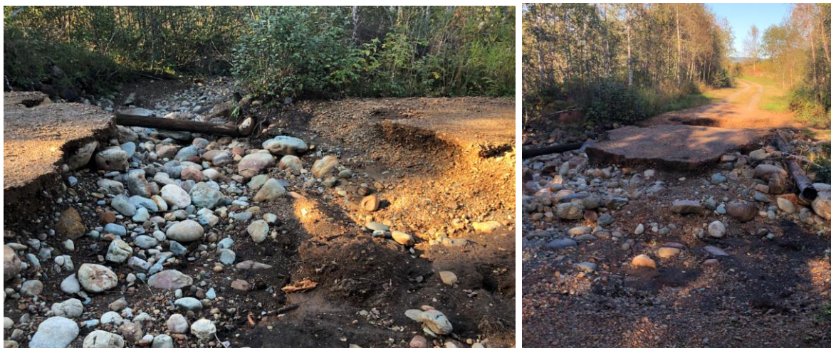
Bilde 27. Veien er vasket bort av Raubekkens flomløp ved forrige nedbørsperiode.
