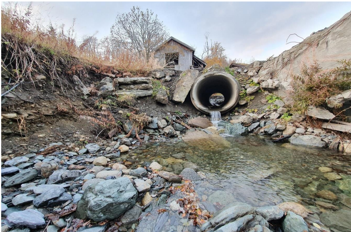
Bilde 139. Kulverten under gårdsveien like nedstrøms naturlig vandringsbarriere i Snoa. Foto: Øyvind Solem, NINA.
