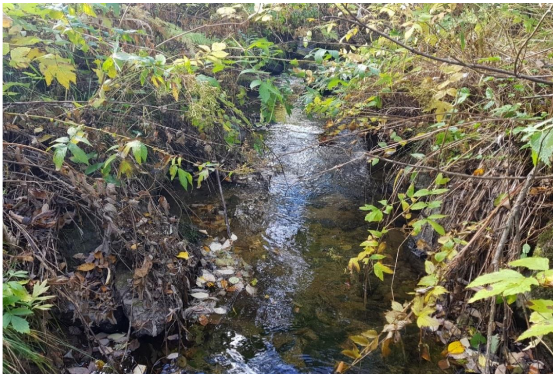
Bilde 56. Nedre elfiskestasjon (16a) ligger helt ned mot kulvert gjennom forbygning og i kanalisert strekning i Tonga. Foto: Øyvind Solem, NINA.
