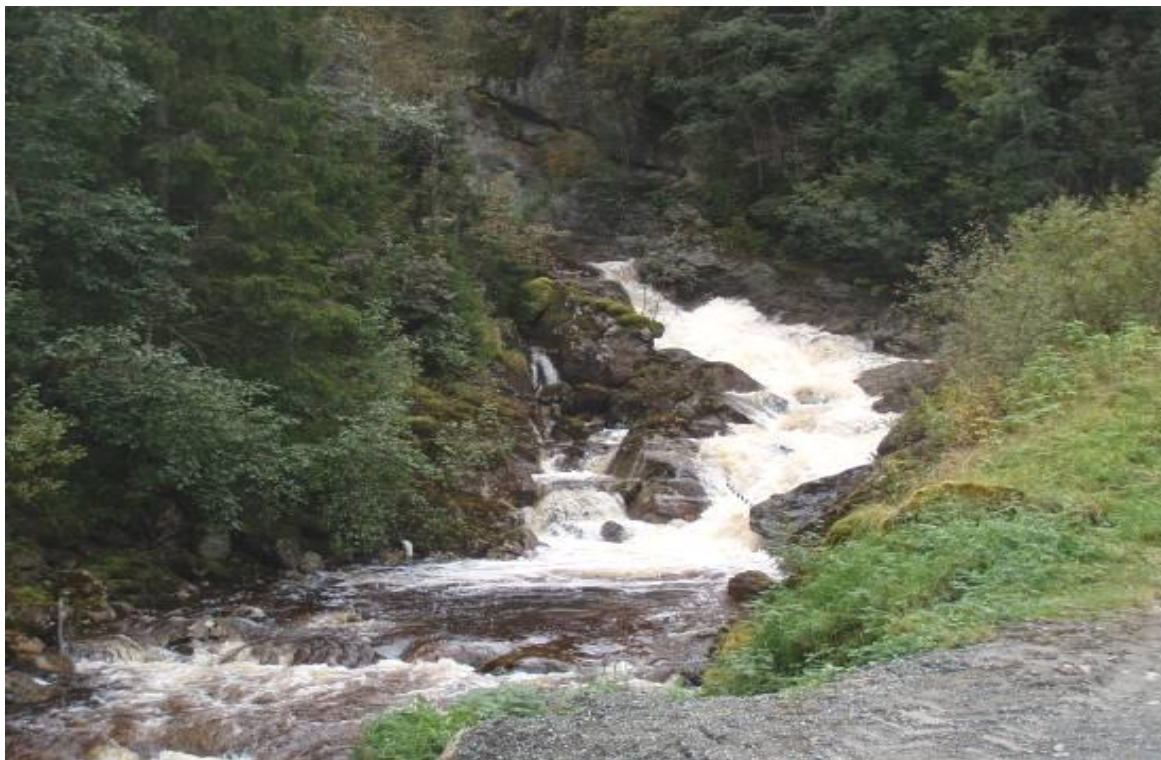
Bilde 129. Naturlig vandringsbarriere for anadrom laksefisk i Mosbrønnskjerwa. Foto på høy vannføring i 2010. Foto: Morten Andre Bergan, NINA.
