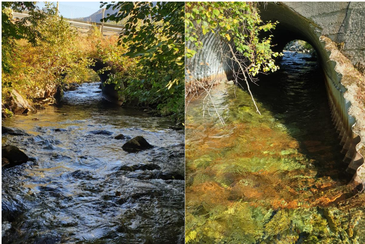
Bilde 162. Kulvert ved Voll skole (til venstre) og kulvert nedstrøms Hurunda Kraftverk (høyre). Begge kulvertene er delvis nedsenket i elvebunnen og har naturlig elvestein i bunnen. Foto: Espen Holthe, NINA.
