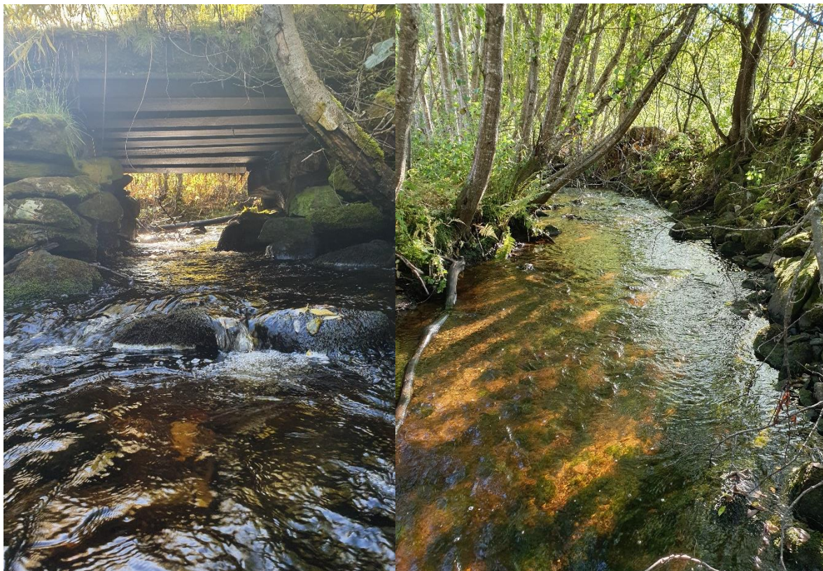
Bilde 187. I nedre deler er bekken forbygd og går langsmed jordekanter (høyre bilde). Oppvandringsfisk har ingen problemer med å passere under ei bru med naturlig bekkebunn (venstre bilde). Foto: Torgeir B. Havn, NINA.
