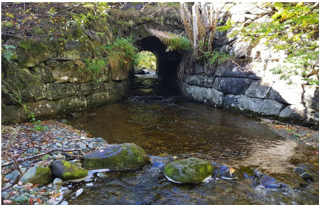
Bilde 117. Kulvert under Fv. 65 høsten 2018. Bunnen består av naturlig stein og anses ikke som et vandringshinder for anadrom laksefisk i Druggu/Litjdruggu. Foto: Øyvind Solem, NINA.
