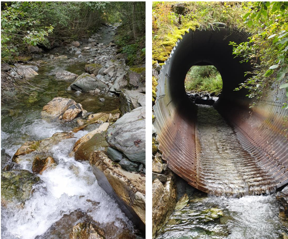
Bilde 193. Bildet til venstre viser vandringsbarrieren sett nedstrøms rett nedenfor veikrysning med kulvert, om lag 250 fra utløpet til Orkla. Stor blokkstein kombinert med et bratt gradient gjør at anadrom fisk fra Orkla ikke klarer å passere dette punktet. Bildet til høyre viser kulvert sett oppstrøms under Fv. 6512. Foto: Marius Berg, NINA.
