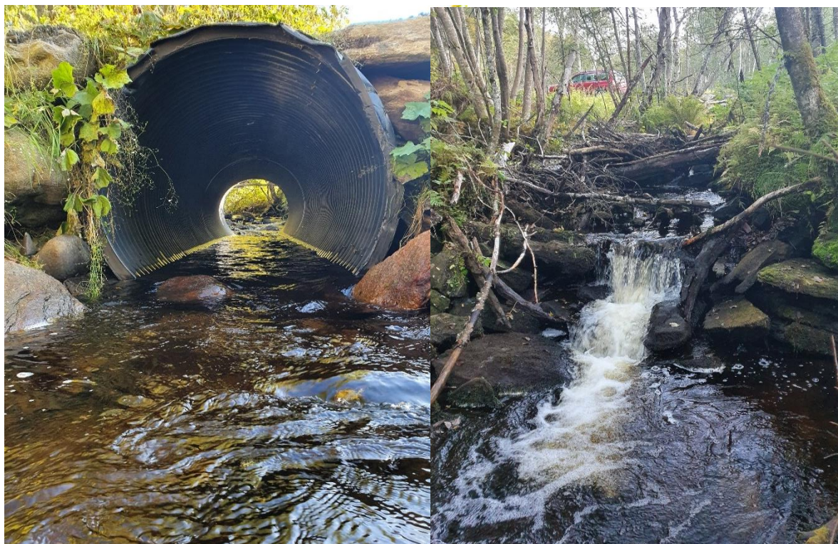
Bilde 190. Bekken går i kulvert under en traktorveg midtveis på anadrom strekning (venstre bilde). Stokker og kvister i bekken utgjør et vandringshinder i øverste del av bekken (høyre bilde). Foto: Torgeir B. Havn, NINA.
