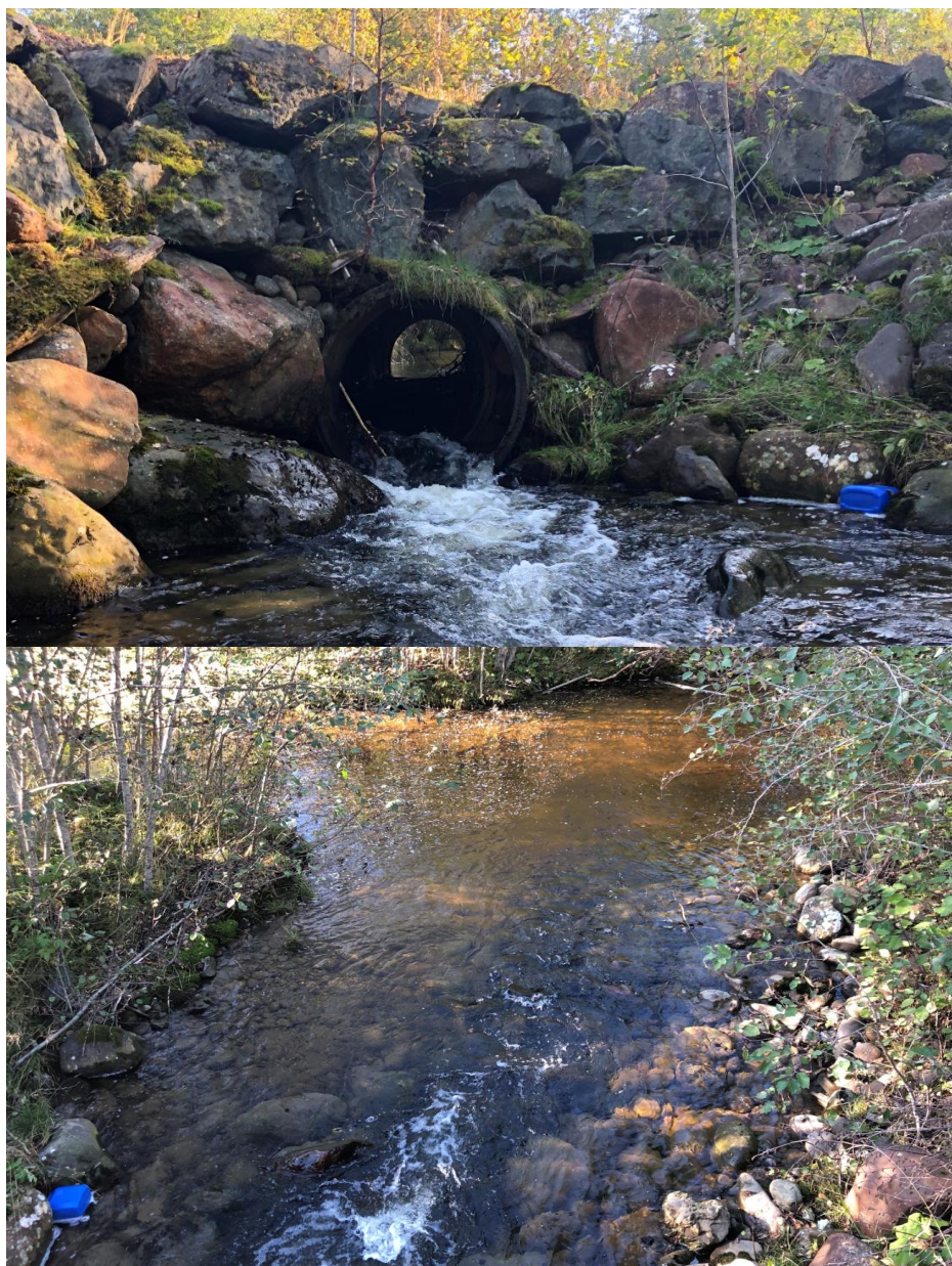
Bilde 24. Kulvert under traktorvei (øverst) og parti nedstrøms. Foto: Morten André Bergan, NINA.
