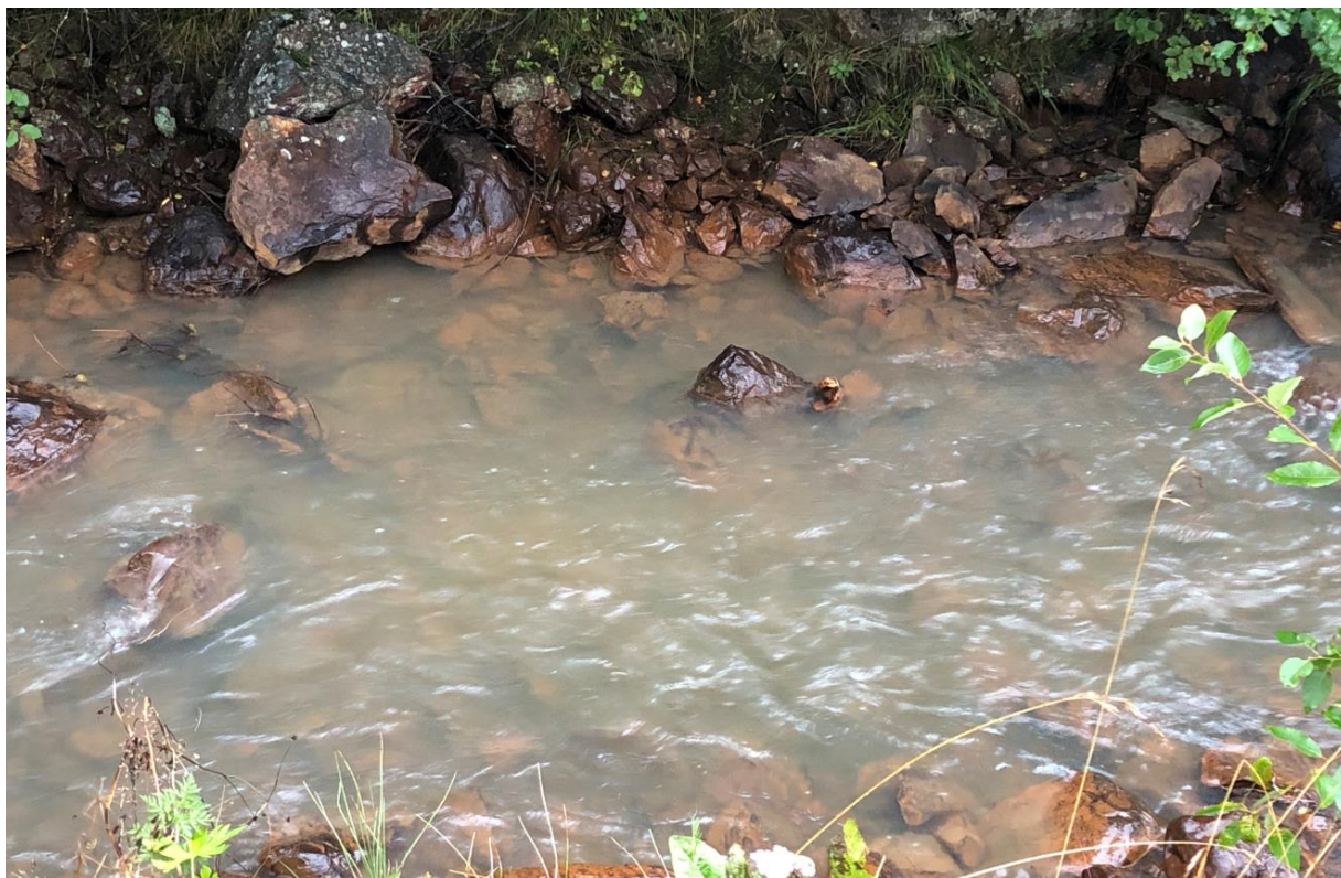
Bilde 21. Raubekken ved Løkken. Foto fra august 2019, tatt like ved Løkken Fotballstadion. Bekkeløpet framstår som svært belastet, rustødt substrat fritt for elvemose, algebegroing eller andre påvekster; en vanlig observasjon i tungmetallpåvirkede ( gjerne kobber) vannforekomster. Foto: Morten André Bergan, NINA.
