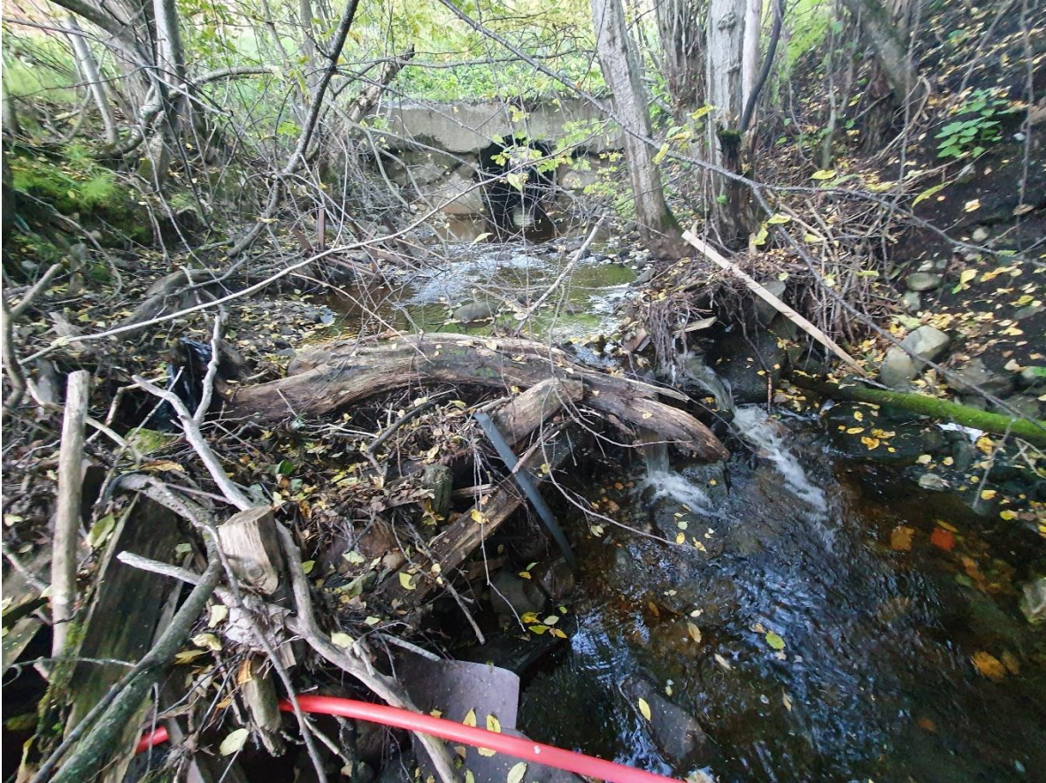
Bilde 157. Sjøppel, kvist og hageavfall nedstrøms kulvert under Fv. 700 hindrer anadrom laksefisk i å vandre fritt opp i Kjåttådna. Foto: Øyvind Solem, NINA.
