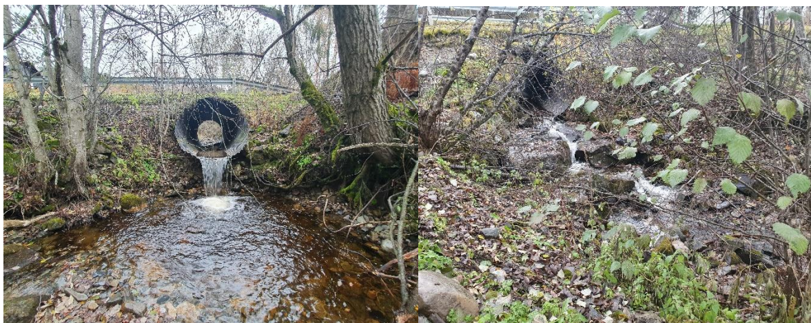
Bilde 102. Kulverter under Ressveien (nordre sidegrein på venstre bilde og søndre sidegrein til høyre). Foto Øyvind Solem, NINA.
