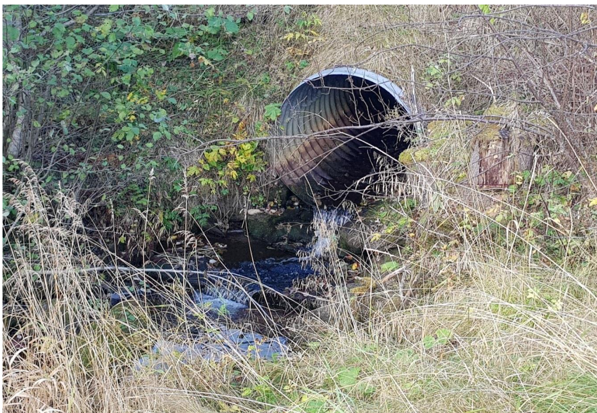
Bilde 55. Utløp av kulvert under Raudkleivvegen. Det er trolig vanskelige oppvandringsforhold for fisk ved de fleste vannføringer. Foto: Øyvind Solem; NINA.
