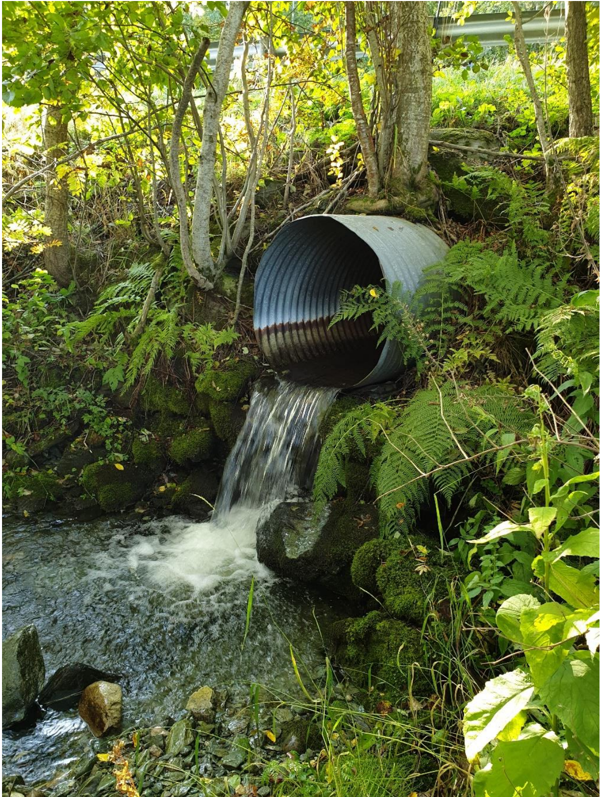
Bilde 195. Miganbekken er lagt i rør under riksveien. Foto: Espen Holthe, NINA.
