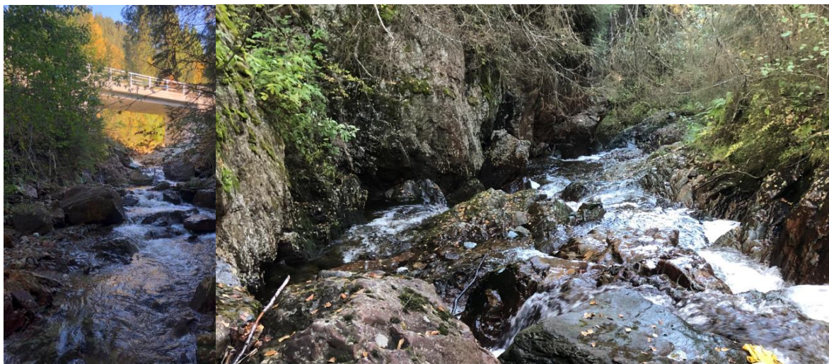
Bilde 22. Raubekken stuper bratt nedover dalsiden etter krysning under Fv. 700 med bru. Foto: Morten André Bergan, NINA.
