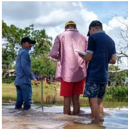
Aforo del dique sobre el caño Betancí.
