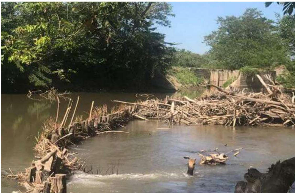
Figura 13. Desviación del río Aracataca en Finca Palo Alto. Fuente: Alcaldía de Pueblo Viejo (2019).
