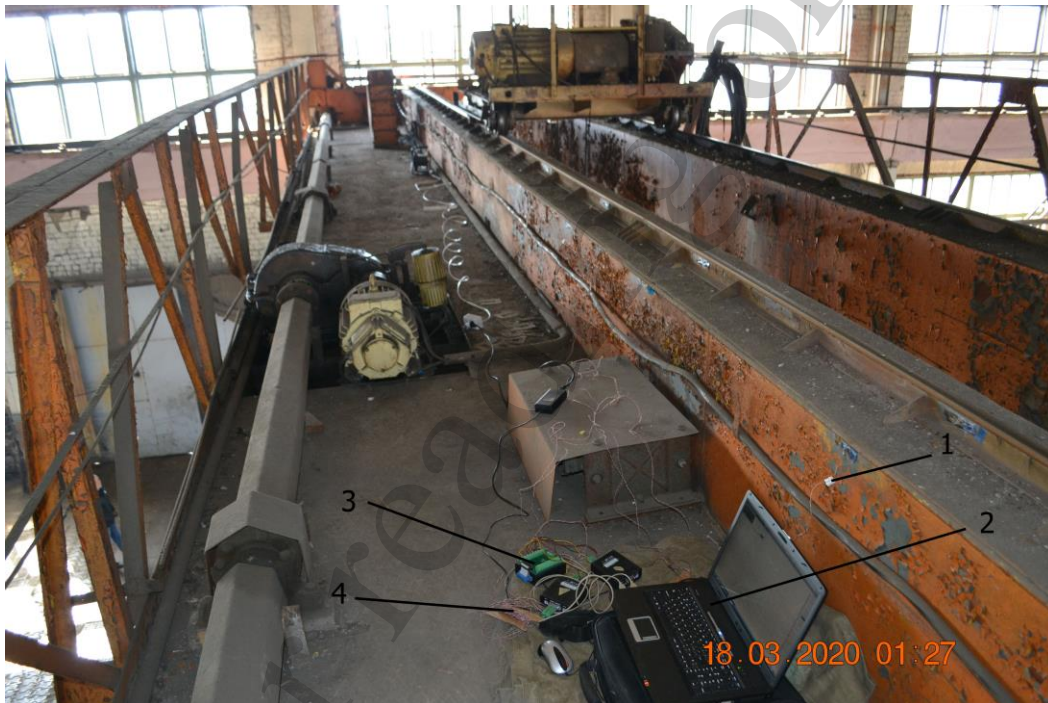
Рис. 3. Загальний вигляд вимірювального обладнання: 1 – клемна колодка; 2 – ЕОМ; 3 – АЦП; 4 – напівмостова схема підключення
