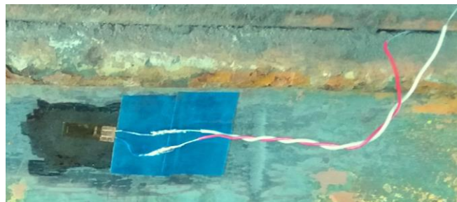
Рис. 2. Приклеювання тензорезисторів на поверхню балки мостового крану
