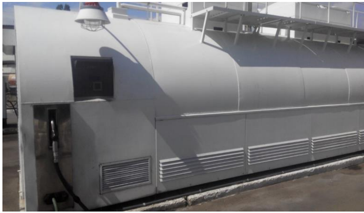
Рис. 7. Автоматична модульна заправна станція
