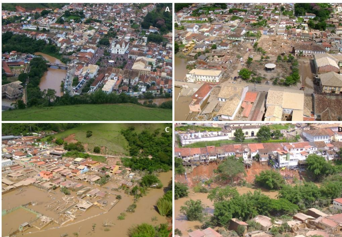
Figura 4: Fotografias do desastre de 2009-2010 em São Luiz do Paraitinga. Praça central e a Igreja matriz antes (A) e depois (B) da inundação de 2009-2010; Bairro alagado (C) e rompimento de taludes (D) na área urbana do município.
