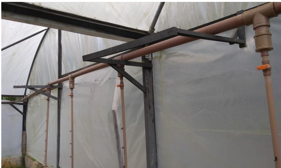
Figura 2: Ampliação e substituição do sistema de aeração com o objetivo de aumentar a pressão de ar deste sistema.
