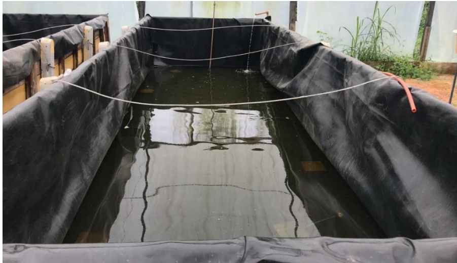
Figura 3: Reparos dos vazamentos do tanque de geomembrana.
