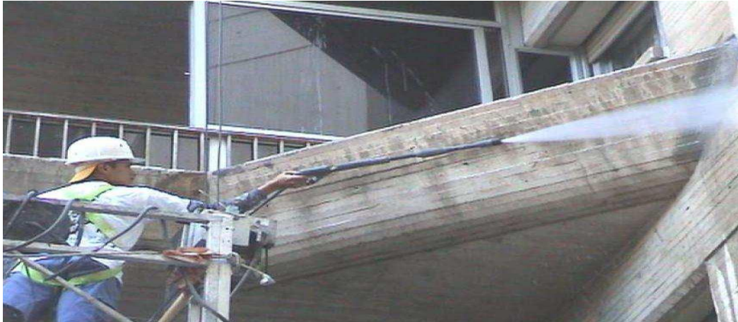
Figura 14 - Decapagem por jato de água com baixa pressão[fonte: Simas 2007]
