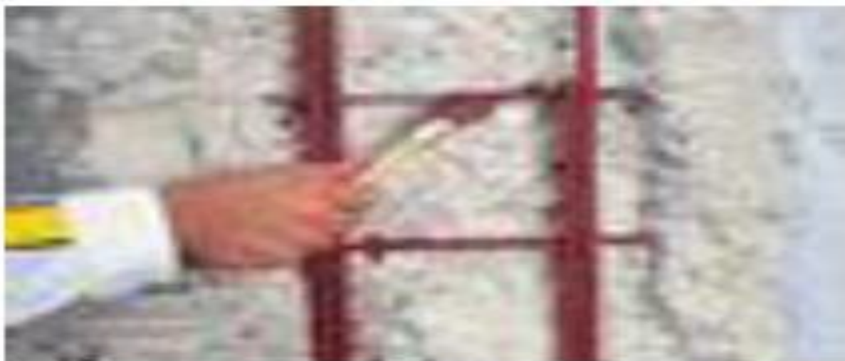
Figura 24 - Revestimento de varões [fonte: Guia Weber, 2008]
