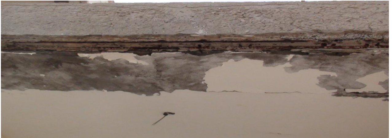
Figura 31 - Viga [fonte: o autor]
