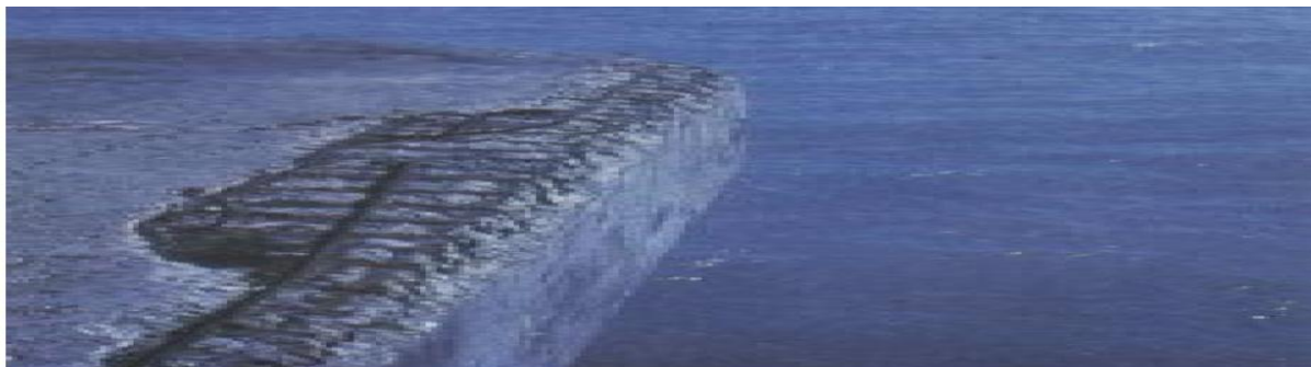
Figura 12 - Corrosão de armaduras por cloretos em estruturas de betão em zona marítima [fonte: HELENE 1988]
