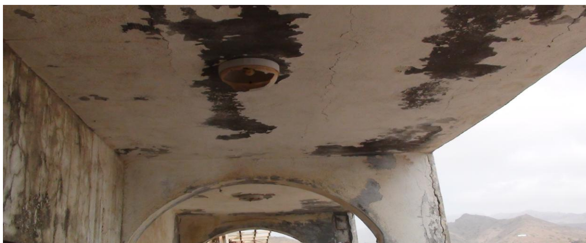
Figura 30 - Teto da laje [fonte: o autor]
