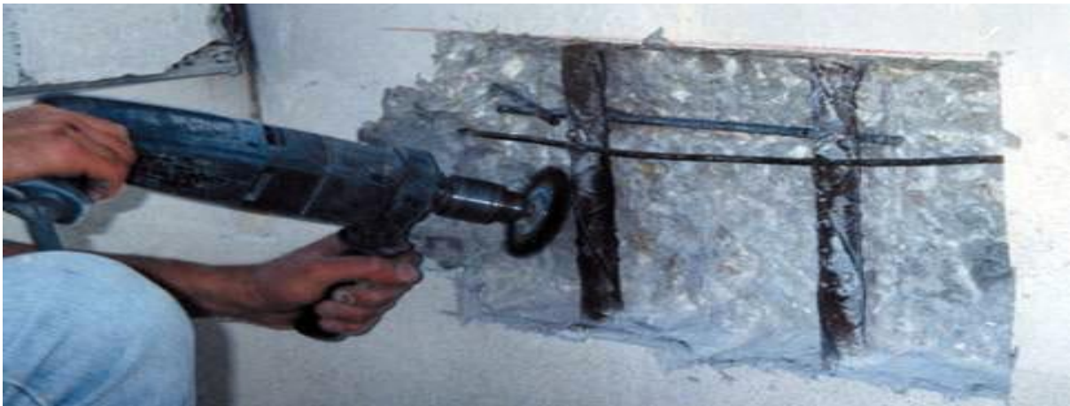
Figura 15 - Limpeza do betão.[fonte: Simas 2007]
