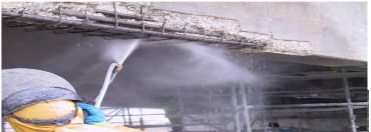
Figura 19 - Limpeza de armadura com jacto de água[fonte: Simas 2001]
