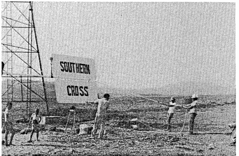
Levantamento de um catavento Southern Cross
