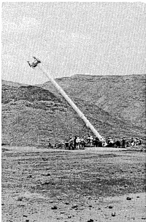
Instalação de um aerogerador da marca Lagerwey v.d. Loenhorst
