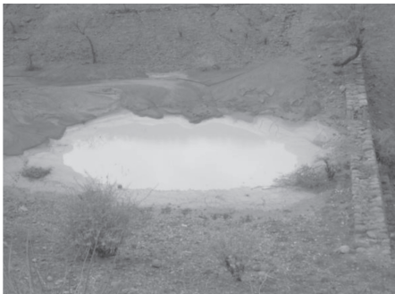
Fotografia 7 Dique de recarga.
