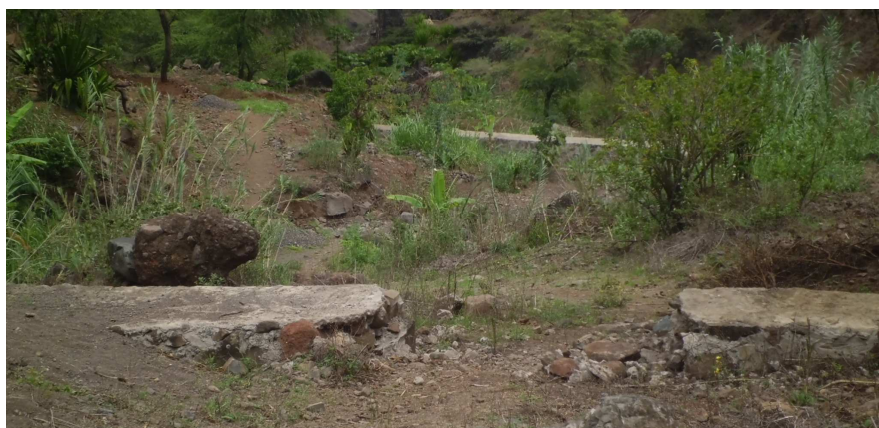
Figura 11 – Dique (de argamassa) de retenção de sedimentos e água com parte da asa removida para permitir a passagem de veículos.
