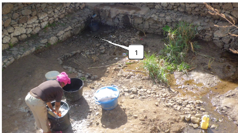
Figura 4 – Dique de correcção torrencial de gabião na sub-bacia de Mato Gégè com função de retenção de sedimentos, onde uma nascente (1) é utilizada para fins diversos.
