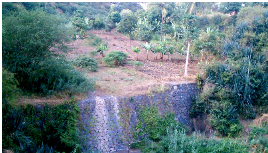
Figura 8 . Dique de regularização. S.Jorge dos Órgãos, Cabo Verde.
