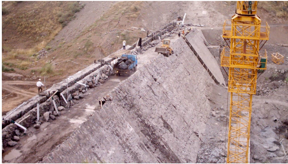
Figura 7. Construção da barragem do Poilão em 2005.
