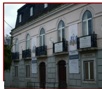
Fig. 8 – Fachada principal da Instituição
