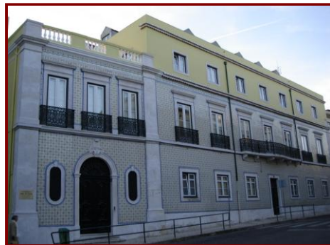
Fig. 19 – Fachada principal da Instituição
