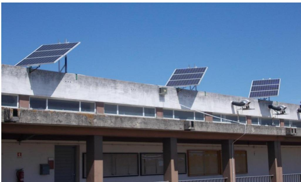
**Figura 5.2 – Fotografia dos painéis instalados realçando o espaçamento entre *strings***
