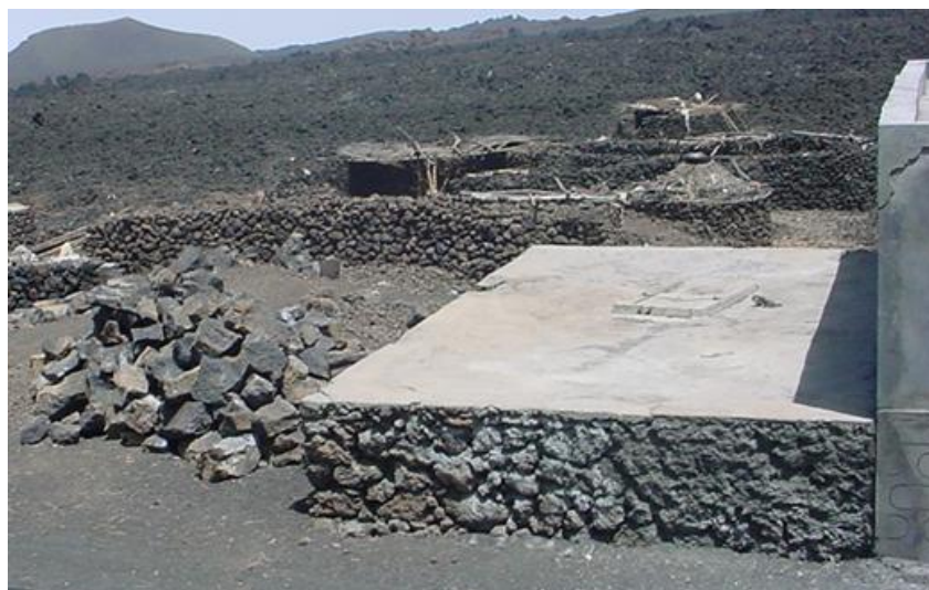
Fig.5 - Cisterna anexa a uma casa na Portela (Chã das Caldeiras).
