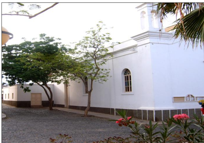
Fig. 7- Fachada lateral esquerda
