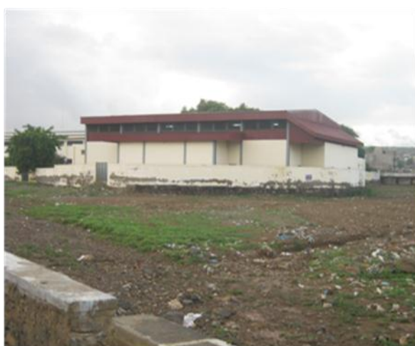
Escola Secundária da Calabaceira (ex-EBC remodelada) Município da Praia
