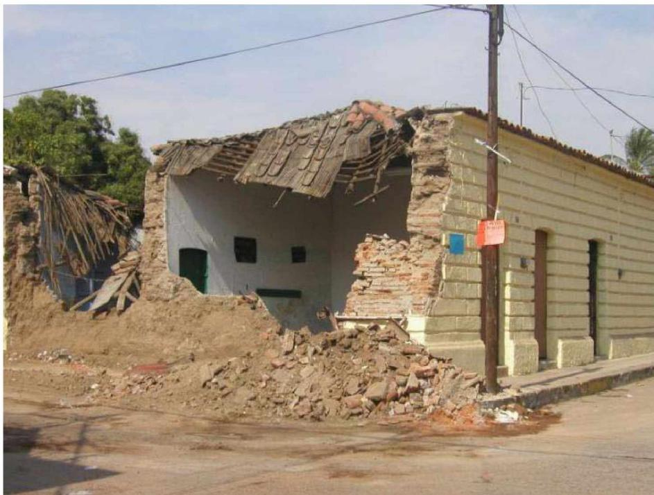
**Figura 11 Daños típicos a estructura esquinera de adobe**
