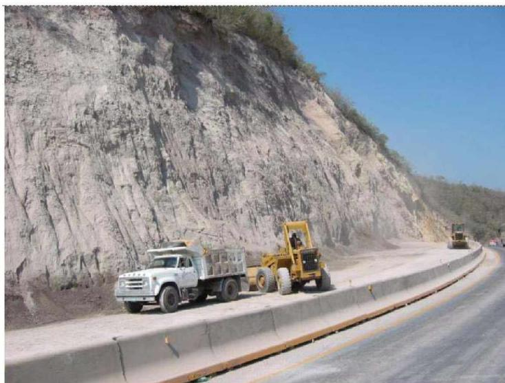
**Figura 17 Derrumbes en la Autopista 110 entre Manzanillo y Colima**
