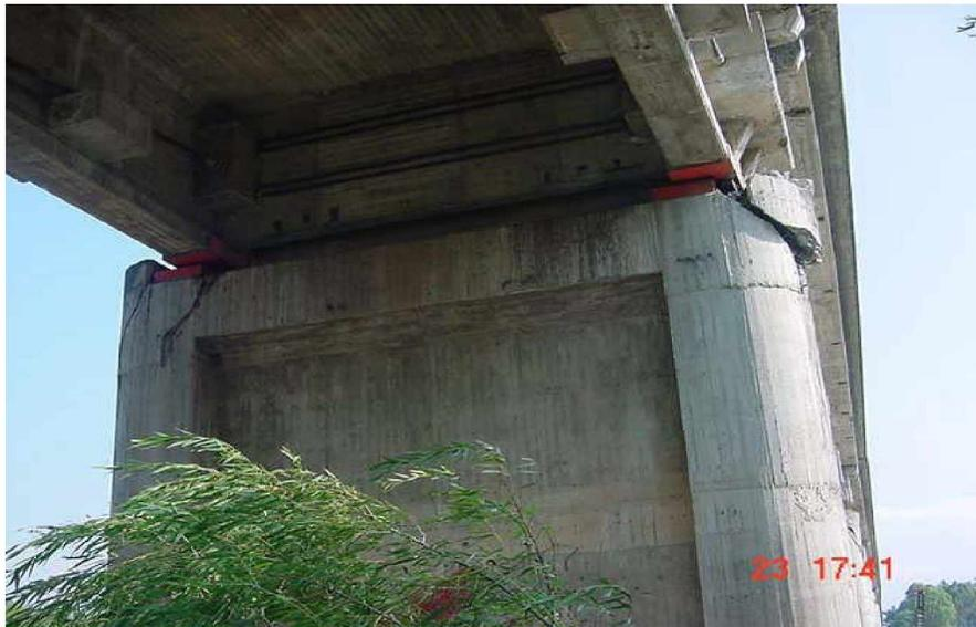
**Figura 16** En la parte superior de la pila se observa a ambos lados que los topes de los sismos fallaron en los desplazamientos laterales de la loza del puente
