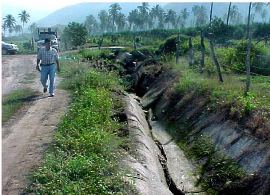
**Figura 14 Daños en el módulo Tecuanillo en el distrito de riego núm. 58**
