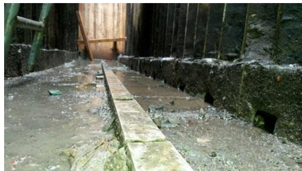
Figura 2-5 Orificios recolectores de lodo.
