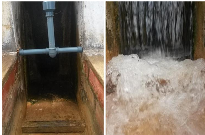
Figura 5-2. Madero colocado en la formación de resalto hidráulico.
