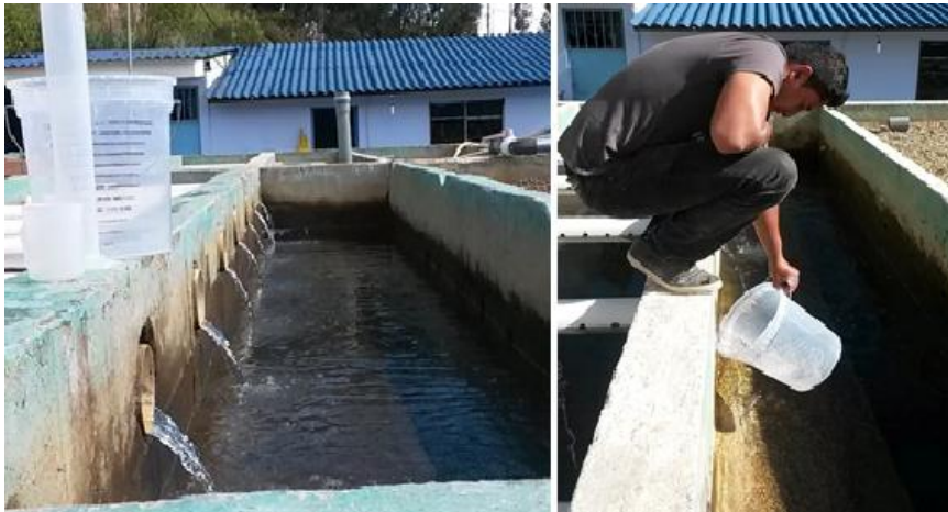
Figura. 4-4 Toma de muestra de agua de los conductos.
