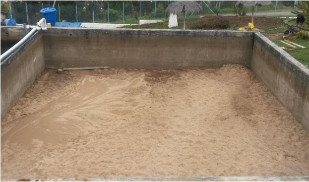
Figura 2-9 Lecho Filtrante (Arena)
