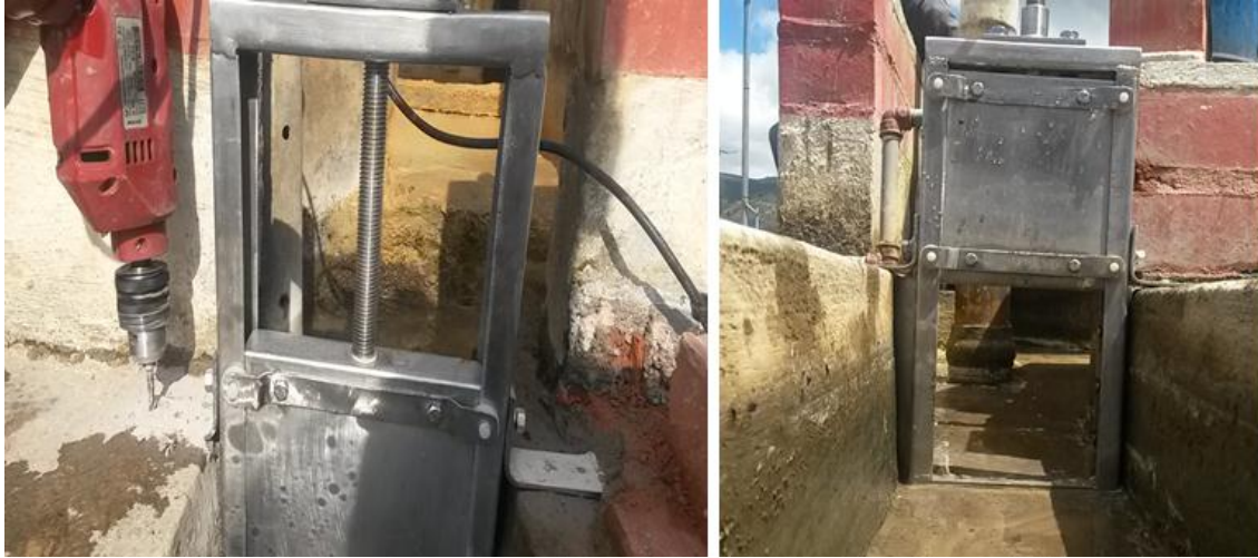
15A: Colocación de las compuertas en los canales de los floculadores
