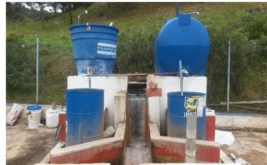
Figura 2-2. Mezcla Rápida
