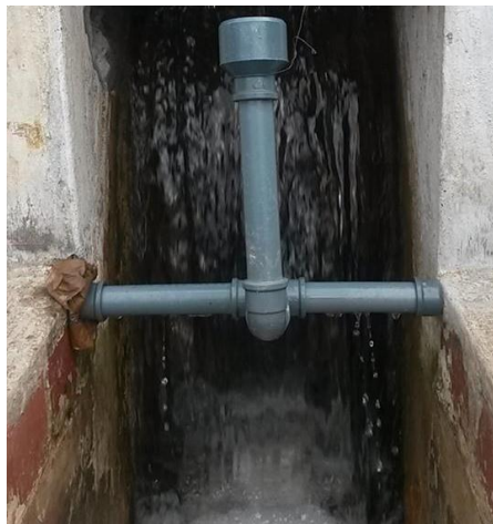
Figura 5-1. Flautín de dispersión de coagulante.
