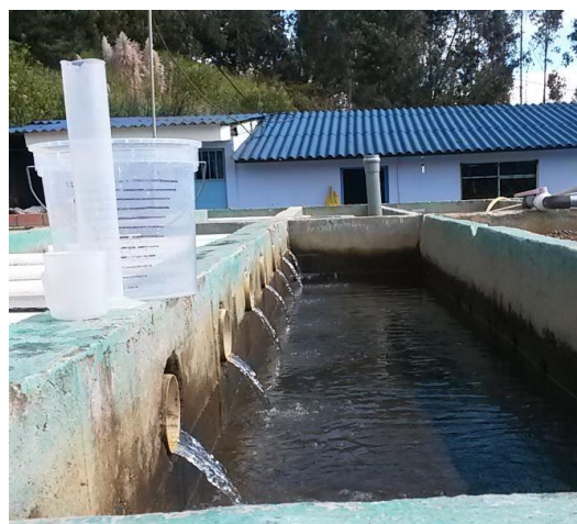
15I: Salida del sedimentador.
