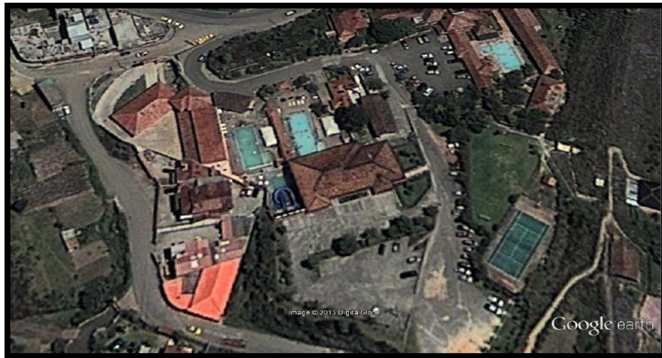
Ilustración # 32 Título: Infraestructura Hostería Autor: Pablo Serrano Fuente: Operaciones hostería Fecha: 30 agosto 2014
