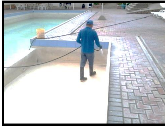
Ilustración # 34 Título: Limpieza de piscina 1 Autor: Rocio Chapa, Deysi Loja Fuente: Propia Fecha: 18 agosto 2014
