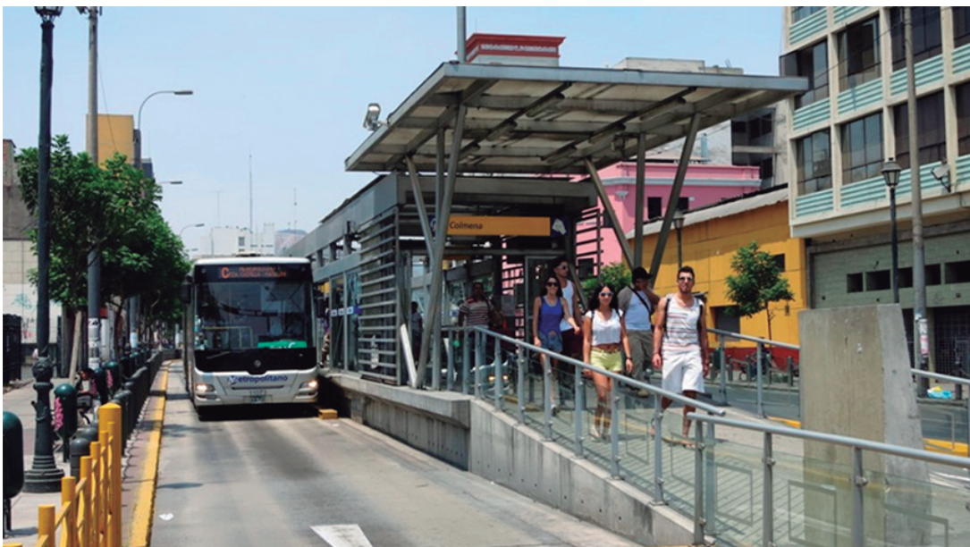
Figura 2. Fotografía de la infraestructura y arquitectura de la estación Colmena (Lima Centro)
