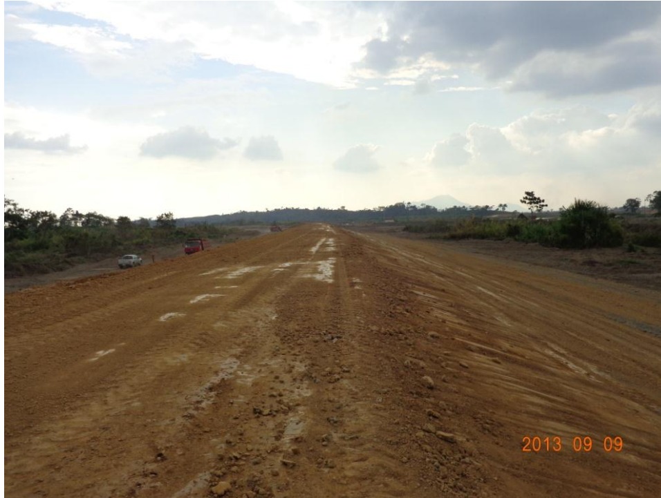
Fotografía 3. Terminado el relleno con arcilla en dique.
