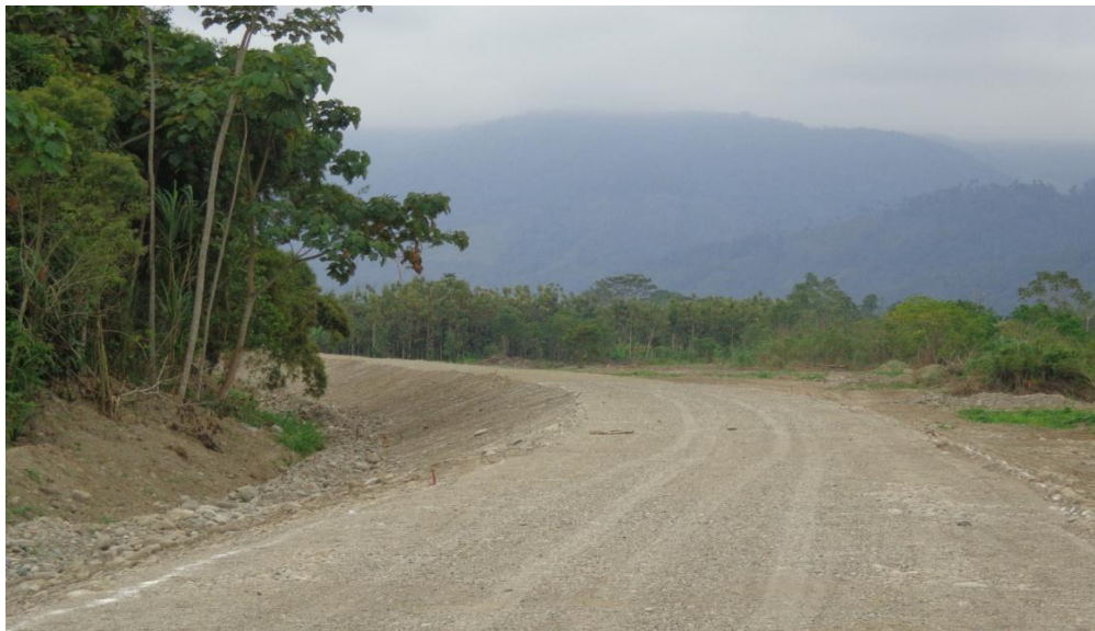
Fotografía 4. Protección con material de mejoramiento sobre corona del dique.
