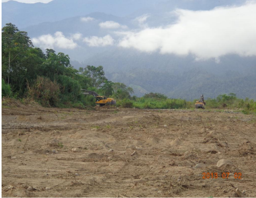
Fotografía 1. Desbroce, desbosque y limpieza en dique.
