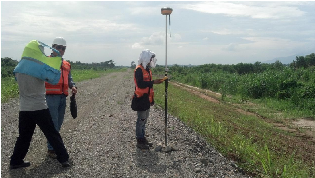
Fotografía 6. Medición de asentamiento con GPS diferencial.
