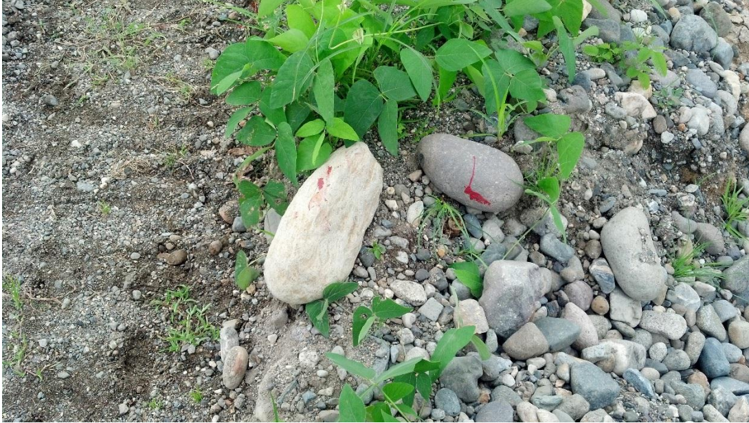
Fotografía 5. Colocación de estacas para medición de asentamientos.
