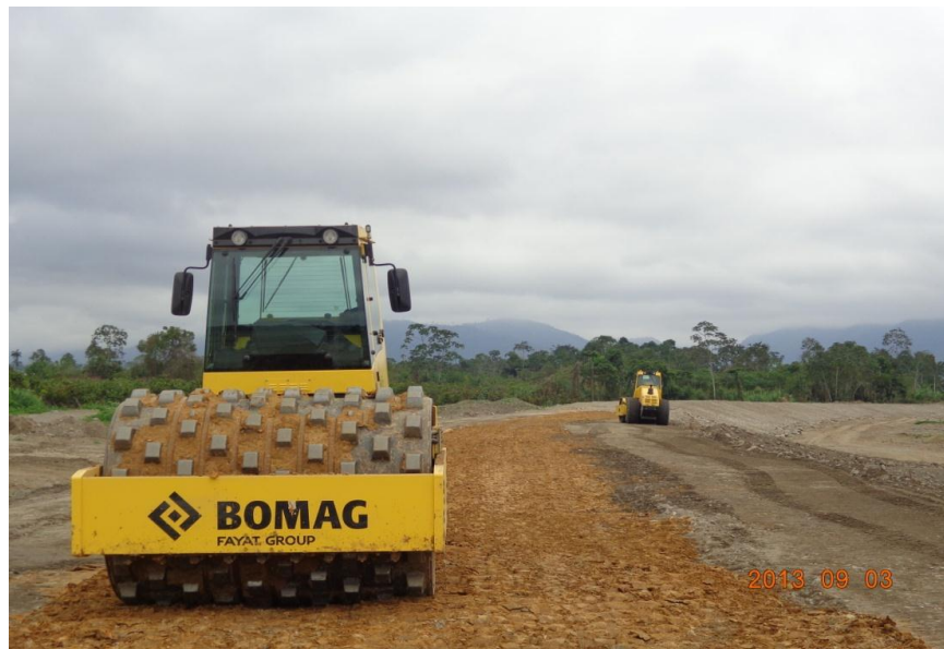
Fotografía 2. Relleno y compactación con material arcilloso en dique.
