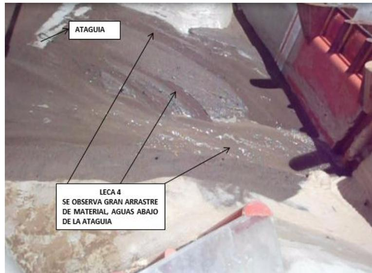
**Fotografía 34. Arrastre de sedimento aguas abajo de la ataguía**
