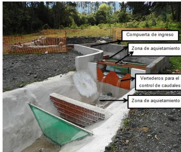
**Fotografía 4. Estructuras de control de caudales y zonas de aquietamiento. Ingreso al tramo del río Jubones**
