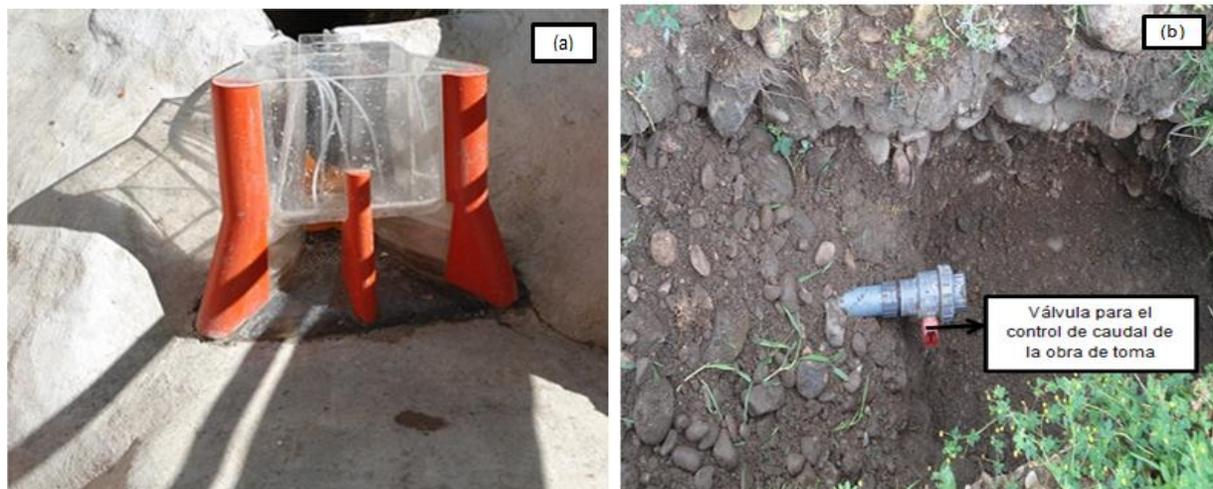
Fotografía 7. (a) Bocatoma. (b) Salida de la obra de toma
