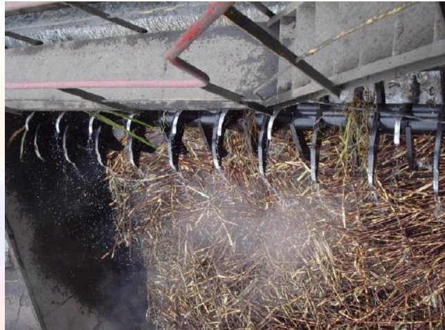
Fig. 9 Conductores de caña Fuente: INGENIO LA TRONCAL, 2011
