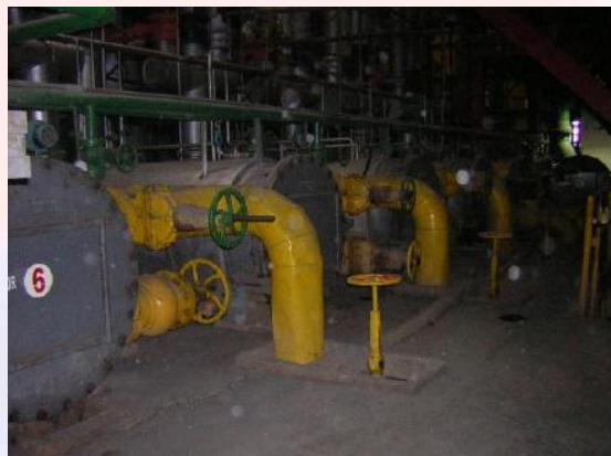
Fig. 13 Evaporadores de jugo Fuente: INGENIO LA TRONCAL, 2011
