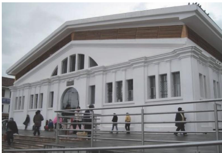
Mercado 9 de Octubre 2011. Cuenca- Ecuador. La fachada ha sido conservada en su totalidad y se han agregado nuevos elementos como puertas de vidrio y celosías de madera sobre los muros exteriores, el interior se ha reconstruido en base a una nueva planificación y diseño.
