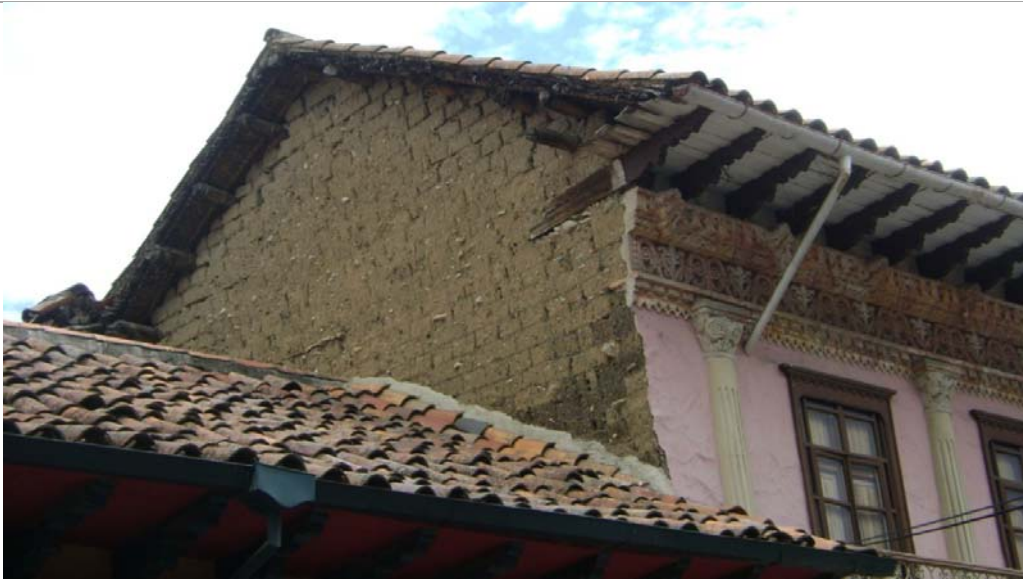
Figura 26: Muestra del material tradicional de una casa del Centro de Cuenca.
