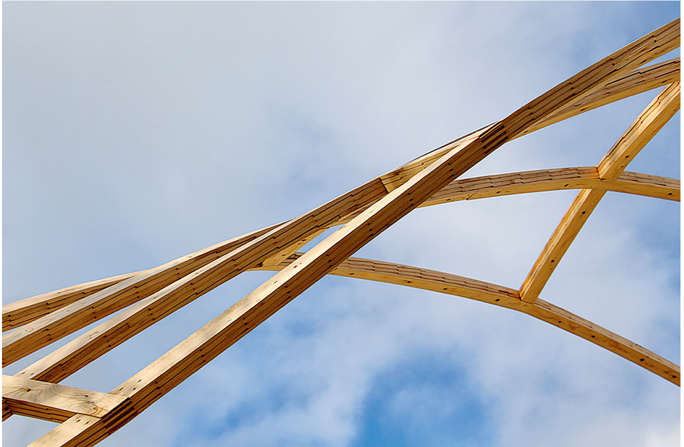
Balken biegen konnten die Zimmerleute bereits vor 300 Jahren. Mit digitalen Methoden wurde die Technik jetzt für komplexe, verdrehte Formen weiterentwickelt.
