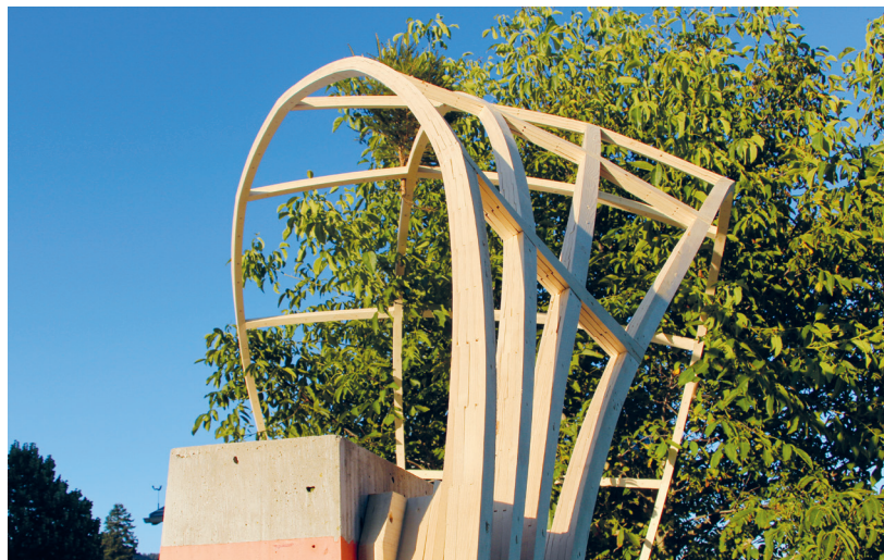
Am Prototyp in Teufen (AR) wird deutlich, wie beweglich die Holzlamellen sind.
