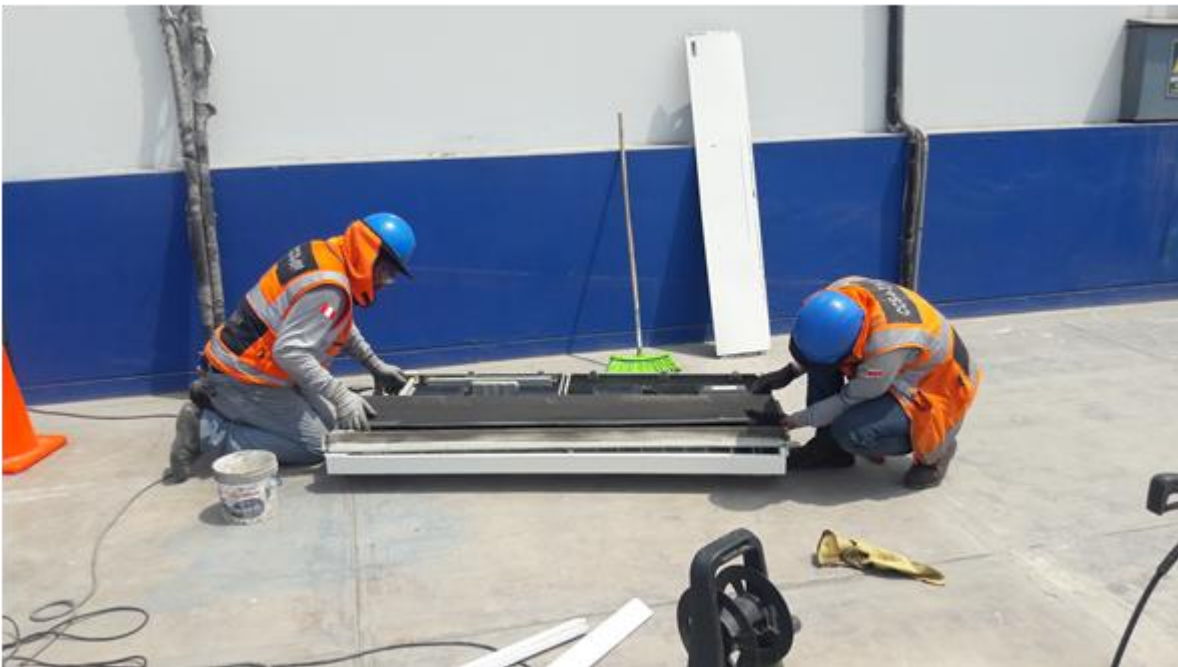
Mantenimiento correctivo de evaporador
