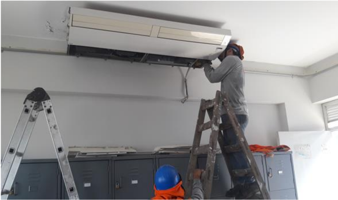
Mantenimiento preventivo de Evaporador
