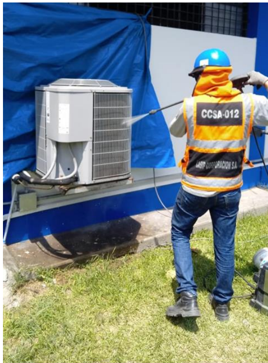
Limpieza de Condensador
