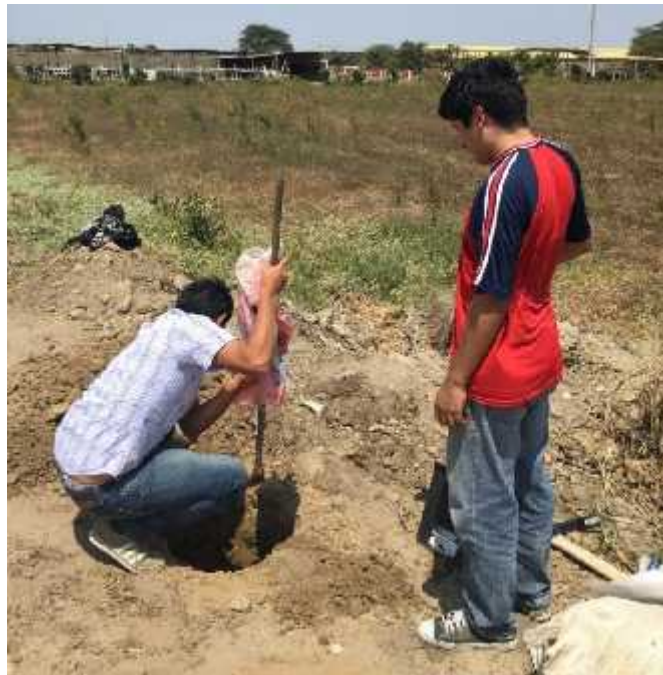
Figura 3.13: Calicata N° 3, se encontró un estrato.
