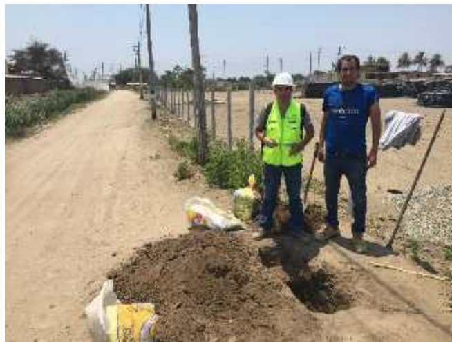
Figura 3.11: Calicata N°1, se encontró un estrato.
