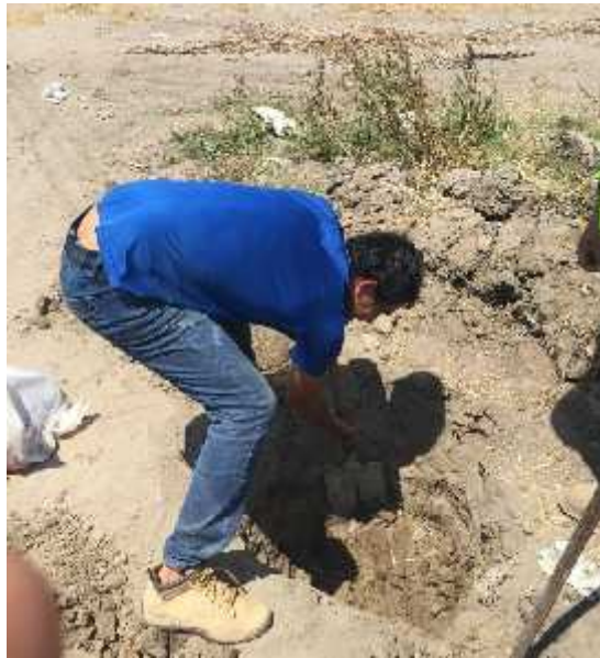
Figura 3.12: Calicata N°2, se encontró un estrato.
