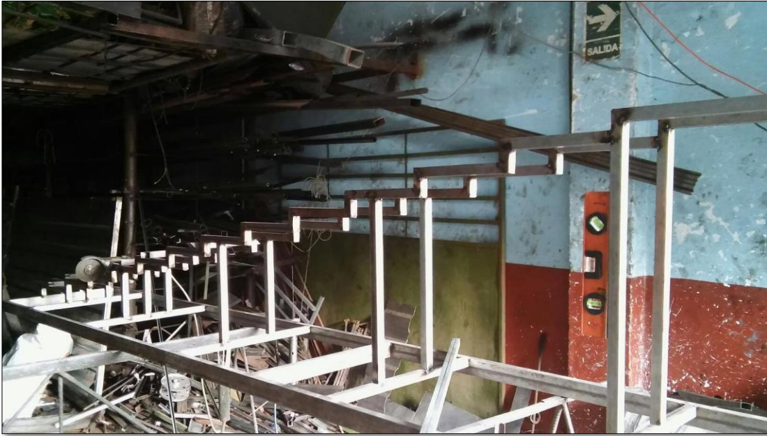
Figura N° 93. Conformación de Estructura Metálica para el Modelo Físico.
