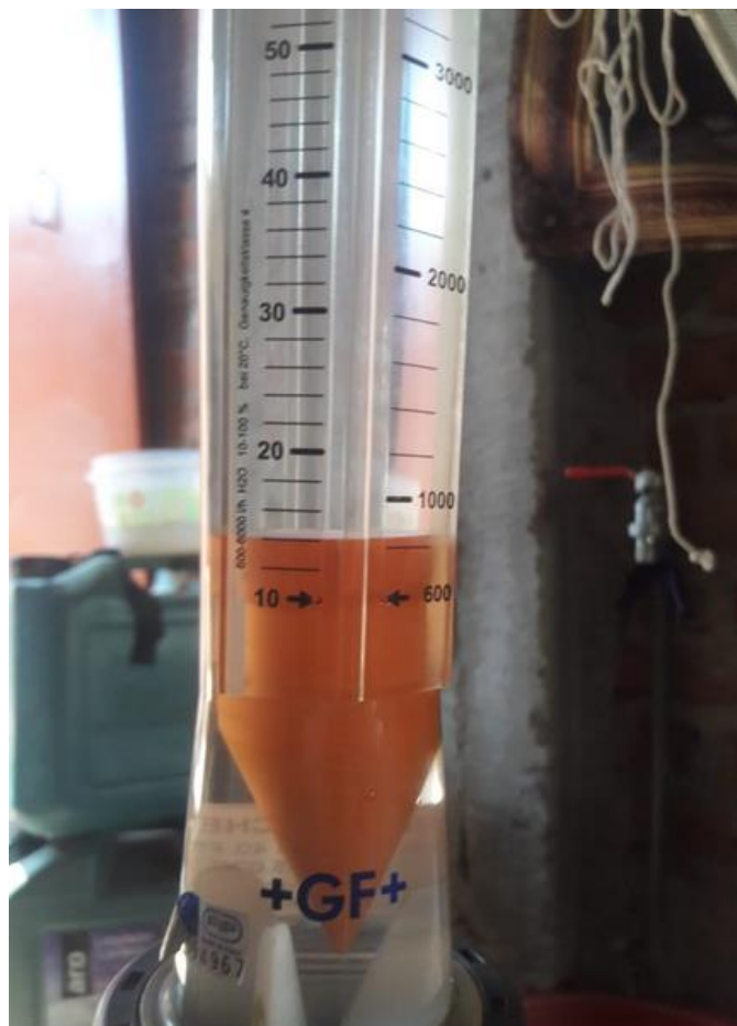
Figura N° 105. Regulación del Caudal por válvula del caudalímetro.
