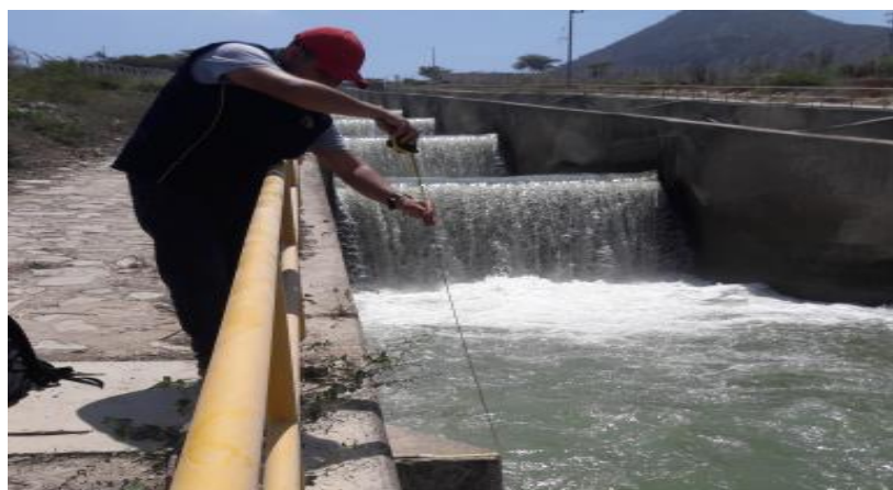
Figura N° 52. Medida de la altura de pared del canal h = 2.33 m
