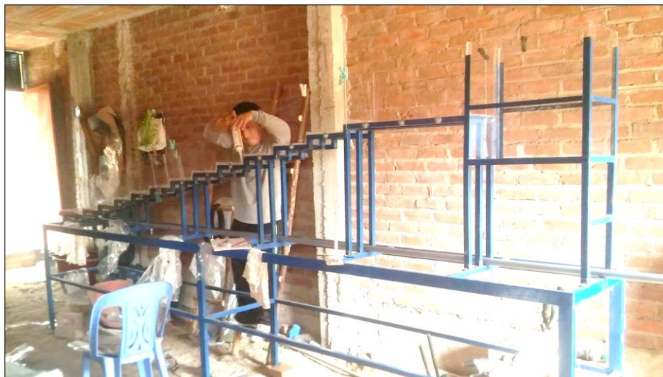
Figura N° 102. Sellado de juntas con silicona del Modelo físico de La Cascada.
