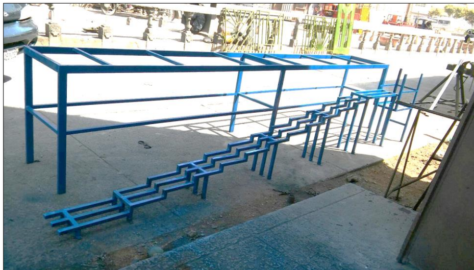
Figura N° 95. Secado de pintura de Estructura Metálica.
