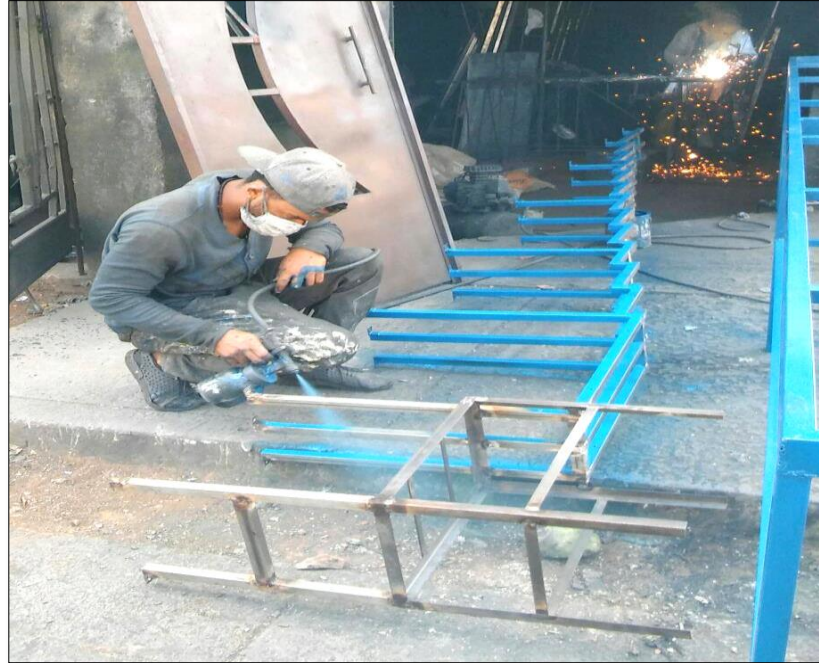
Figura N° 94. Pintado de Estructura Metálica para el Modelo Físico.
