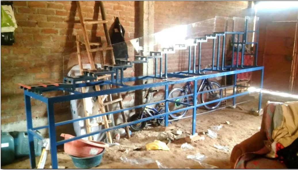
Figura N° 99. Montaje de pared izquierda del canal.
