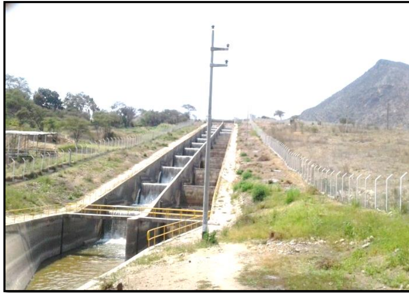
Figura N° 9. Caída Escalonada La Cascada – Chongoyape - Chiclayo
