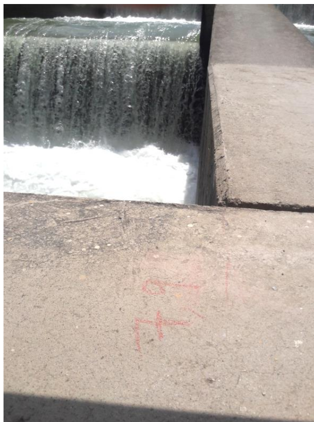
Figura N° 51. Medida del Ancho del Canal W = 7.95 m
