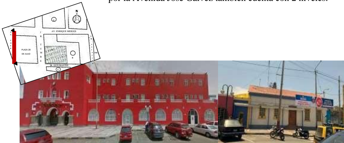
Figura N° 13 : Foto del perfil de Av. José Gálvez. Fuente: Elaboración propia.
