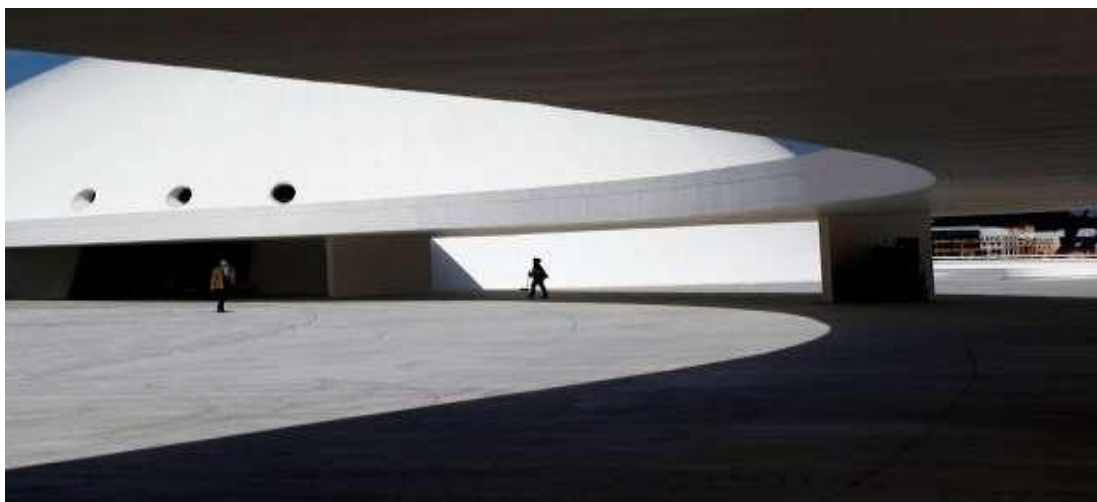
Figura N° 65: vista del Centro Niemeyer. Fuente https://diario16.com
