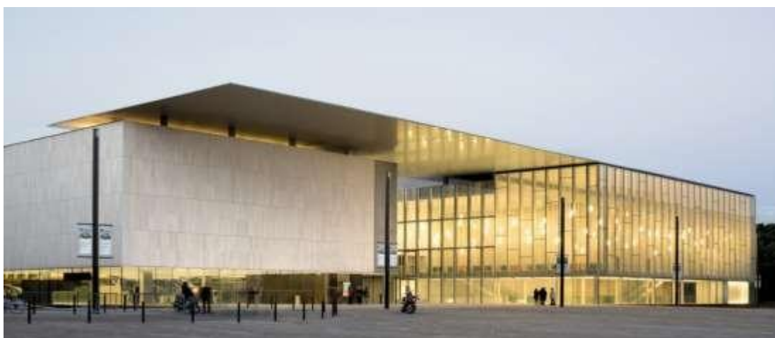
Figura N° 66: Centro Cultural Les Quinconces. Fuente https://www.archdaily.pe
