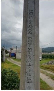
Imagen 15. Diseño de PCR-13-600, con sus especificaciones (Fuente: Elaboración propia).
