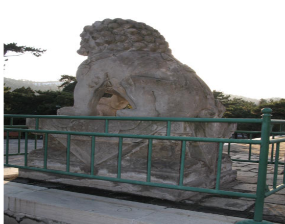
图23石狮底座：雨水冲刷引起沉淀
