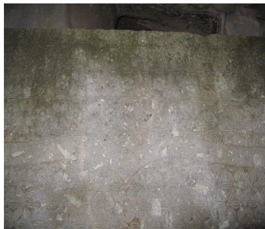
图18石象底座：微生物，风化，变色
