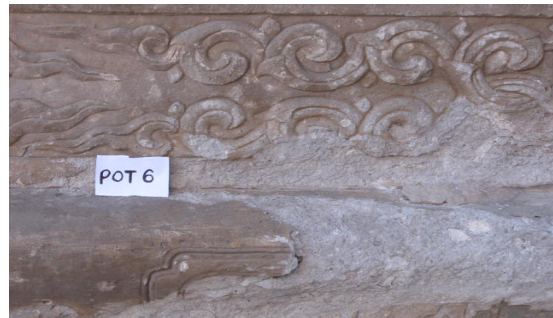
图11石狮底座：盐性粉化剥落
