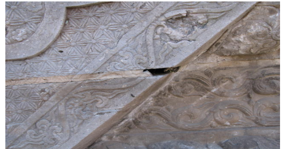
图16 石狮底座：不恰当的水泥沟缝
