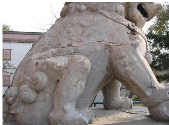
图21 石狮侧面：裂縫，缺失
