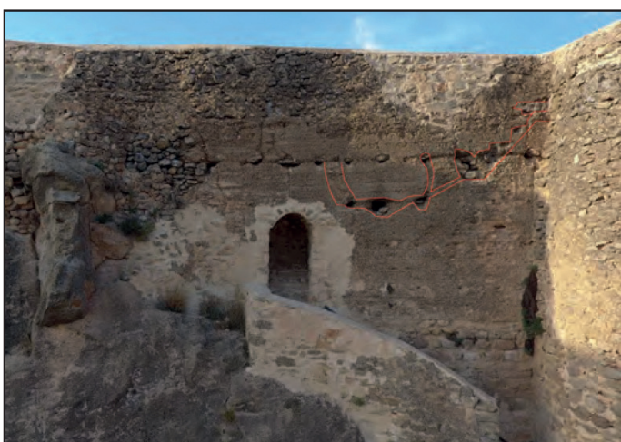
Figura 12. Improntas del sistema de andamiaje para la construcción del cubo.
