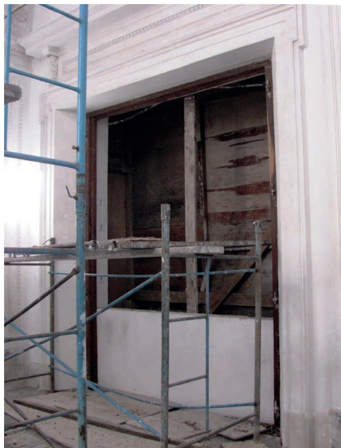
Figura 7. Puerta descubierta empotrada en la pared que correspondería al altar, que indica que en origen la capilla estaba orientada hacia el lado opuesto al actual. Fotografía: Daniel Schávelzon.
