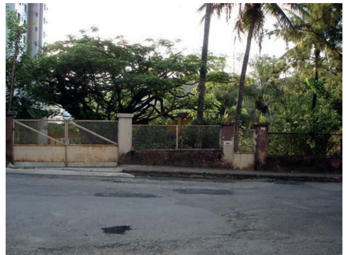
Figura 1. Vista de muro perimetral de una casa de la década de 1960. Fotografía Zarankin 2006.
