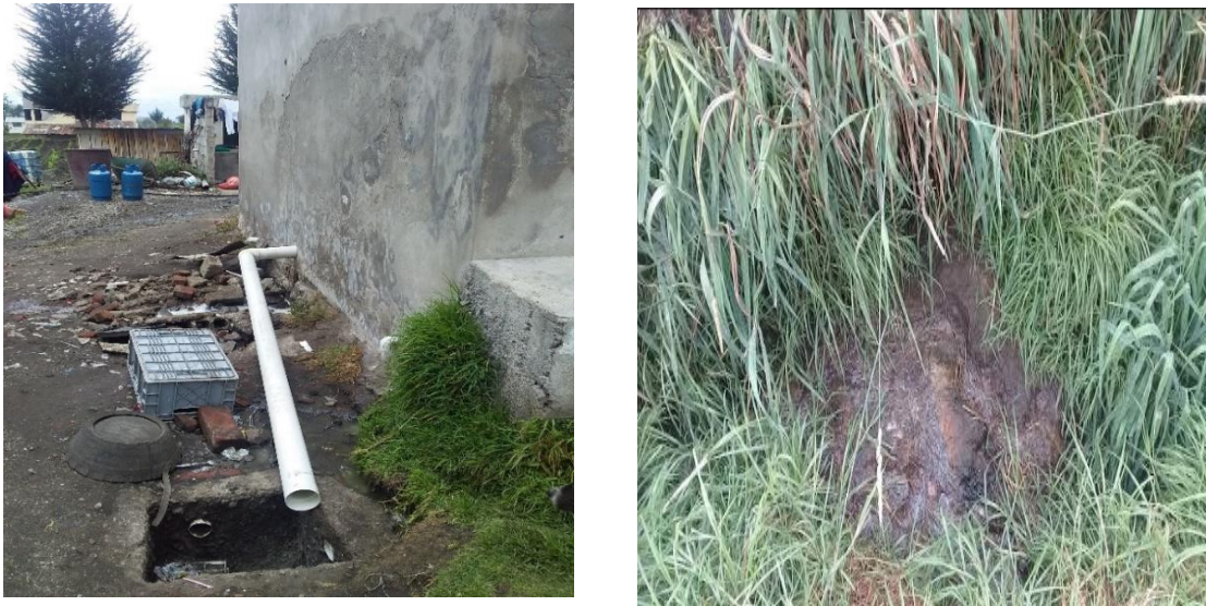
Figura 7-3: Recorrido de los efluentes líquidos de la quesera artesanal
