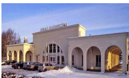
4. attēls. Rīga, Upju stacija Balasta dambī 9, 1946.-1950. Arhitekts: N. Voronovs. ( http://e.znet.lv/Arhitekt_stili_Latvija_Text.pdf )
