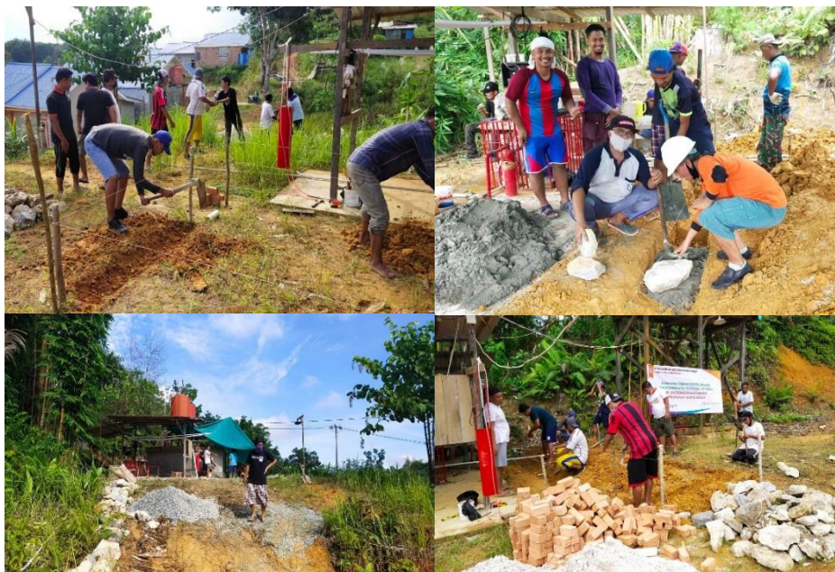
Gambar 7. Pengerjaan Struktur Bak Penjernihan
