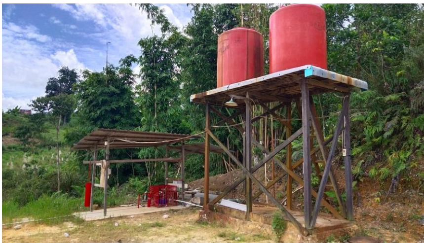
Gambar 2. Proses Penampungan dan Filtrasi yang pernah di coba di Rt 36 Graha Indah
