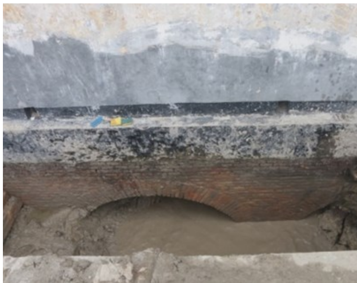
Gambar 7. Bentuk lengkungan pada fondasi bangunan A di kotak TBS2017T16S3 (Sumber: Purnawibowo, et.al. , 2017:28).
