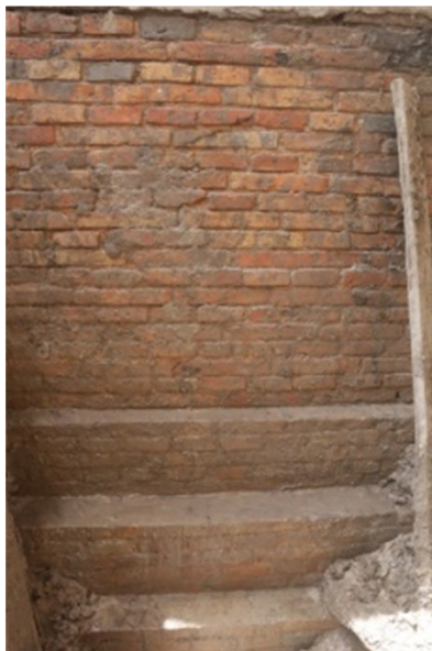
Gambar 4. Detil susunan bata pada fondasi bagian bawah yang tampak di kotak TBS2017T9S10 (Sumber: Purnawibowo, et.al. , 2017:28).
