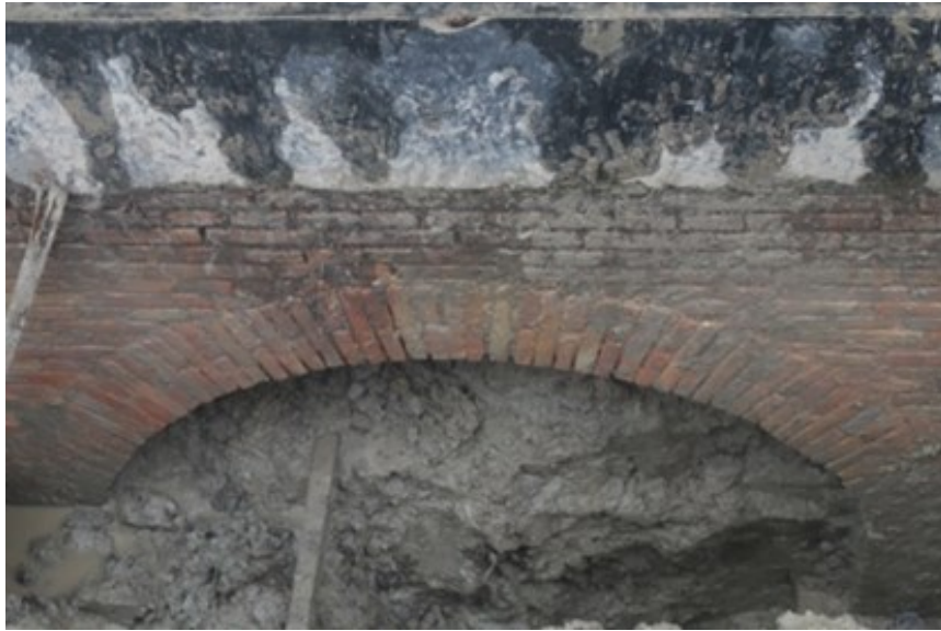
Gambar 8. Lapisan lumpur yang berada pada rongga fondasi bangunan A di kotak TBS2017T16S3 (Sumber: Purnawibowo, et.al. , 2017:26).
