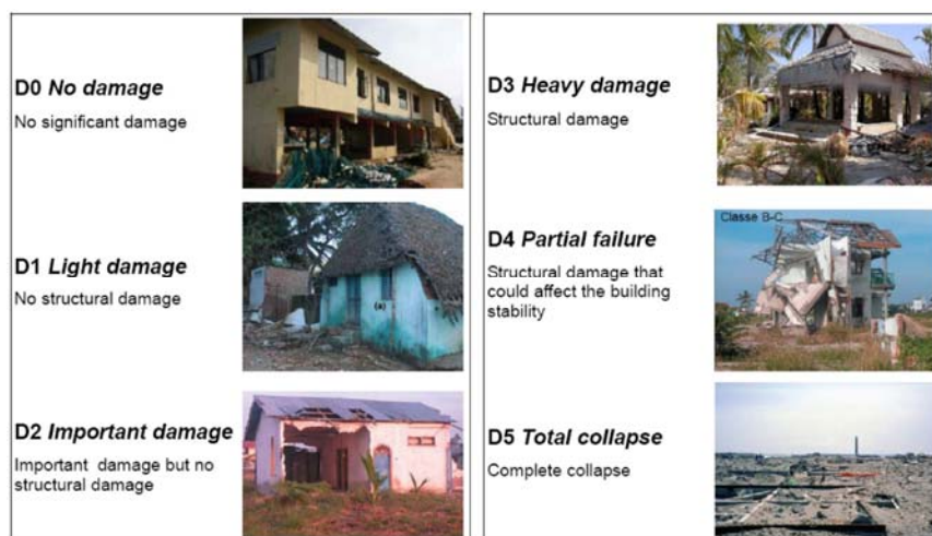
Figura 23: Exemplos de danos em edifícios, associados à matriz de danos proposta na Tabela 6. As fotos são do tsunami de 2004 no Oceano Índico (fontes: Leone et al. 2010, Peiris 2006 e Garcin et al. 2007)
