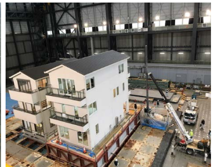
(3) B 棟設置後の電柱敷設時
