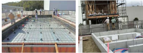
(2) B 棟 RC 造べた基礎施工
