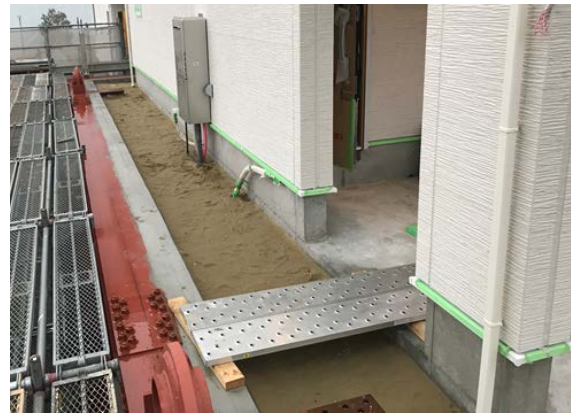
(3) B 棟 RC 造べた基礎上に上部構造施工
