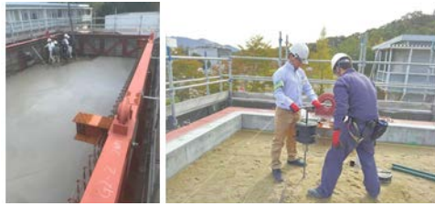
(1) B 棟の土槽製作
