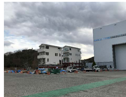
(5) 施工現場 (左 A 棟、右 B 棟)
